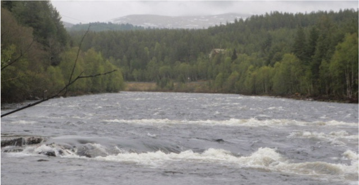
Figur 6-6 Oppstrøms dam og inntakssted ved Lensmannsfossen
