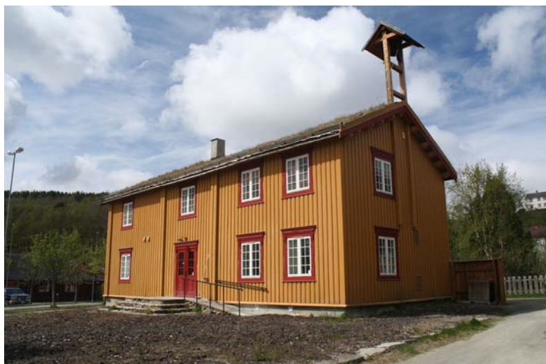
Bilde 4-6: Tolga smeltehytte med malmplassen, nyere tids kulturminne, (Vedlegg 2), Brennmoen, delområde Gammelbrua-Tolga-Tolgensli.
