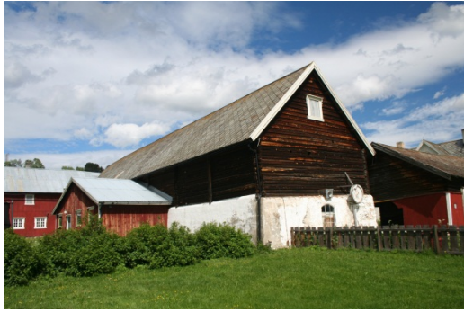
30. Driftsbygning og stall Sted: Erlia, østre SEFRAK-ID-nr.: 4360016098 Registrert av: Torbjørn Røberg, Odel Dato: 7.7.2010
