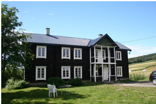
70. Hovedbygning Sted: Tollan SEFRAK-ID-nr.: 4360016063 Registrert av: Torbjørn Røberg, Odel Dato: 8.7.2010
