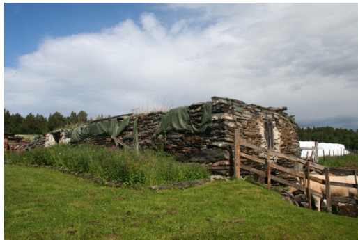
71. Driftsbygning Sted: Tollan SEFRAK-ID-nr.: 4360016062 Registrert av: Torbjørn Røberg, Odel Dato: 8.7.2010
