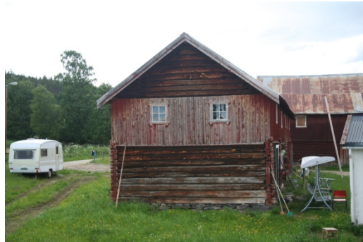
100. Stall, vognskjul og løe Sted: Heskestø SEFRAK-ID-nr.: 4360016047 Registrert av: Torbjørn Røberg, Odel Dato: 8.7.2010
