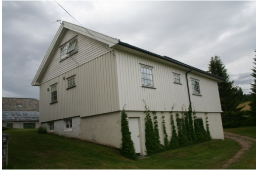
48. Våningshus (revet, nybygg oppført) Sted: Rønningen SEFRAK-ID-nr.: Ikke oppgitt Registrert av: Torbjørn Røberg, Odel Dato: 7.7.2010
