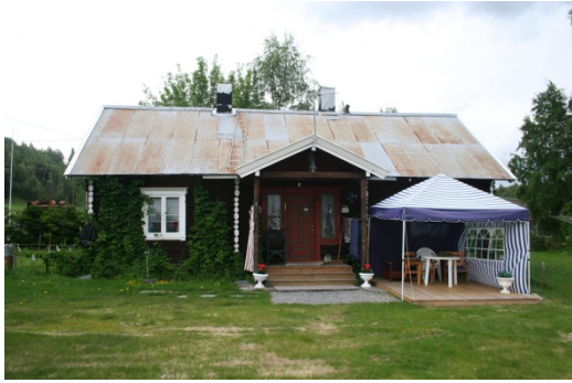
66. Stuebygning Sted: Hagen, østre SEFRAK-ID-nr.: 4360016067 Registrert av: Torbjørn Røberg, Odel Dato: 8.7.2010
