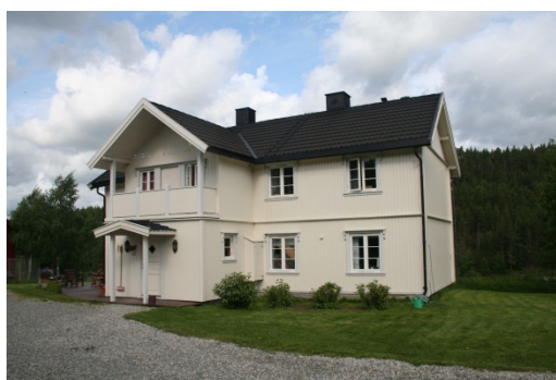
115. Hovedbygning Sted: Eidet, søndre SEFRAK-ID-nr.: Ingen opplysninger Registrert av: Torbjørn Røberg, Odel Dato: 8.7.2010
