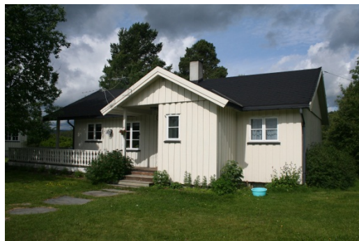
119. Hovedbygning (revet, nybygg oppført) Sted: Eidet, nordre SEFRAK-ID-nr.: 4360017004 Registrert av: Torbjørn Røberg, Odel Dato: 8.7.2010
