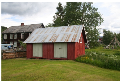
93. Uthus (bygning fra 1890-årene) Sted: Sandmel SEFRAK-ID-nr.: Nyregistrert Registrert av: Torbjørn Røberg, Odel Dato: 8.7.2010
