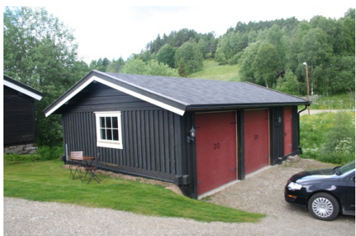
92. Tuft, fjøs (fjernet, nybygget garasje) Sted: Sandmel SEFRAK-ID-nr.: 4360015167 Registrert av: Torbjørn Røberg, Odel Dato: 8.7.2010
