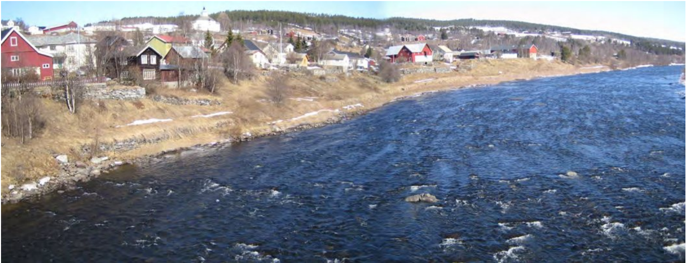
Bilde oppstrøms Tolga bru ved 12 m 3 /s vannføring.
