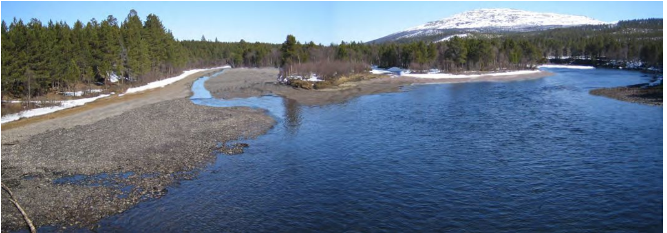
Bilde oppstrøms Erlien bru ved 5 m 3 /s vannføring. Bildet er manipulert.
