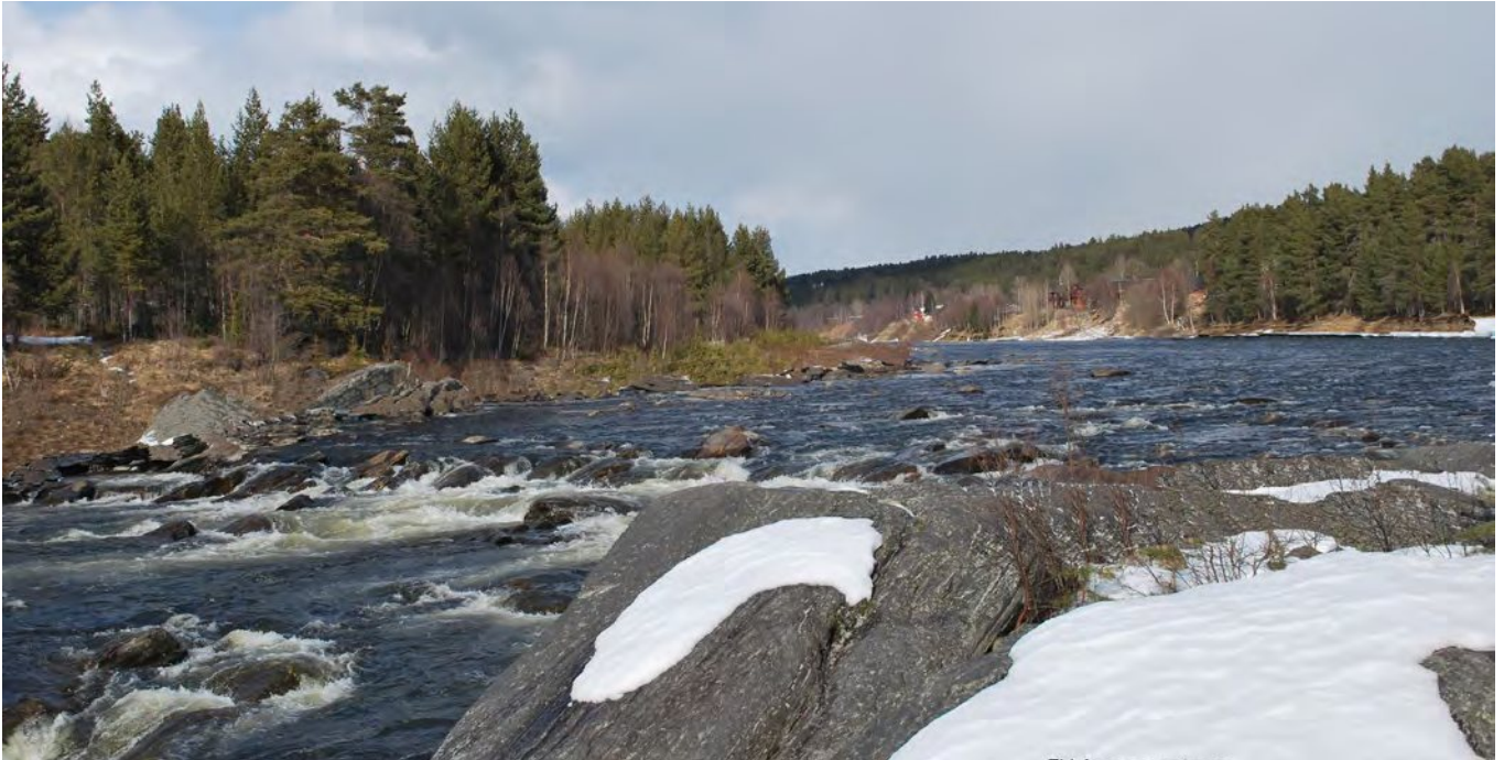
Bilde oppstrøms Eidsfossen ved 12 m 3 /s vannføring.
