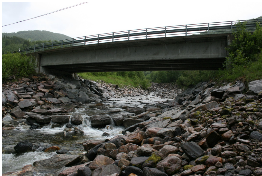
Bilde 7: Elveløp under bru, sett motstrøms.
