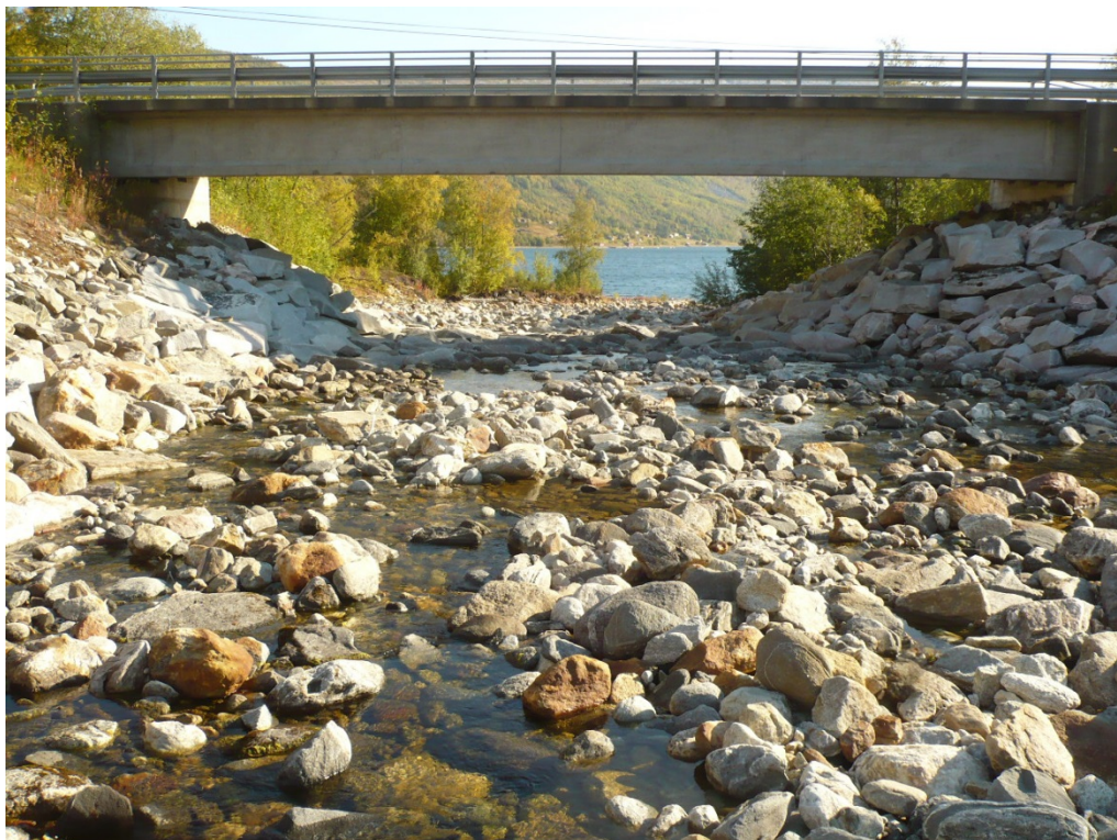
Bilde 10. Bru på riksvei 812. Misværfjorden i bakgrunnen.
