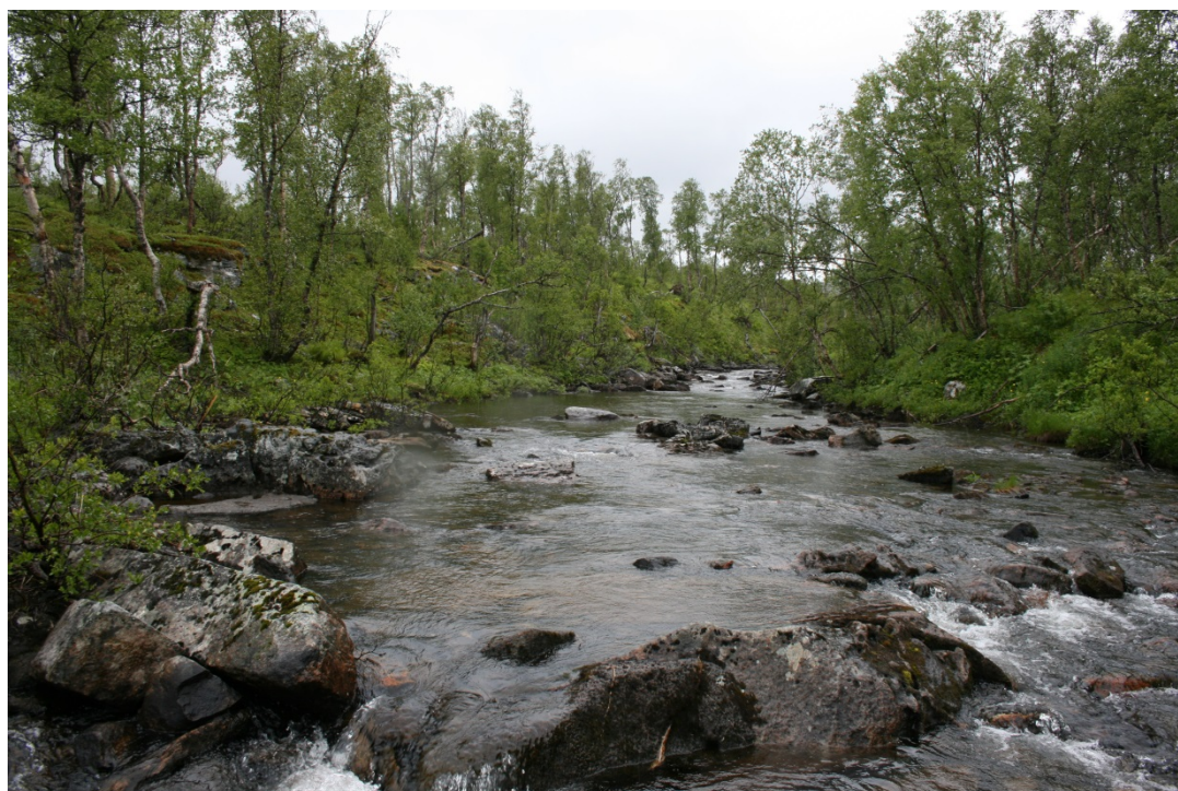
Bilde 4: Damsted, sett motstrøms.
