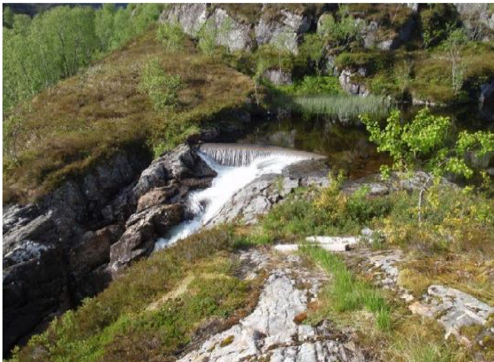
Bilde 1. Vanninntak i Brautvatnet
