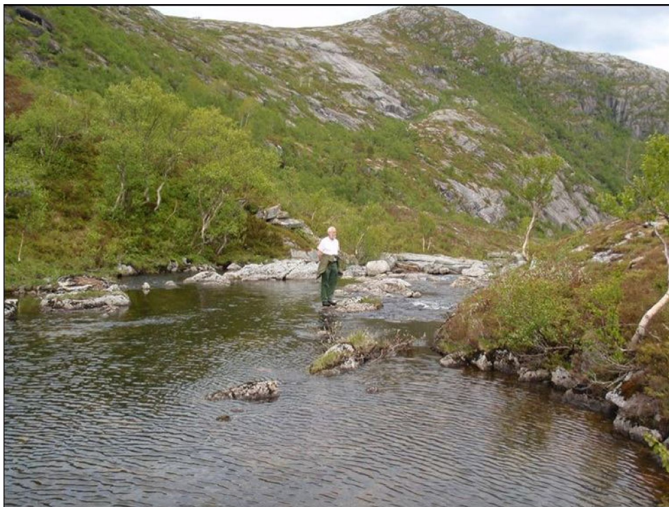
Bilde 6. Plassering av terskel på fjell i utløpet fra Jakopdalsvatnet
