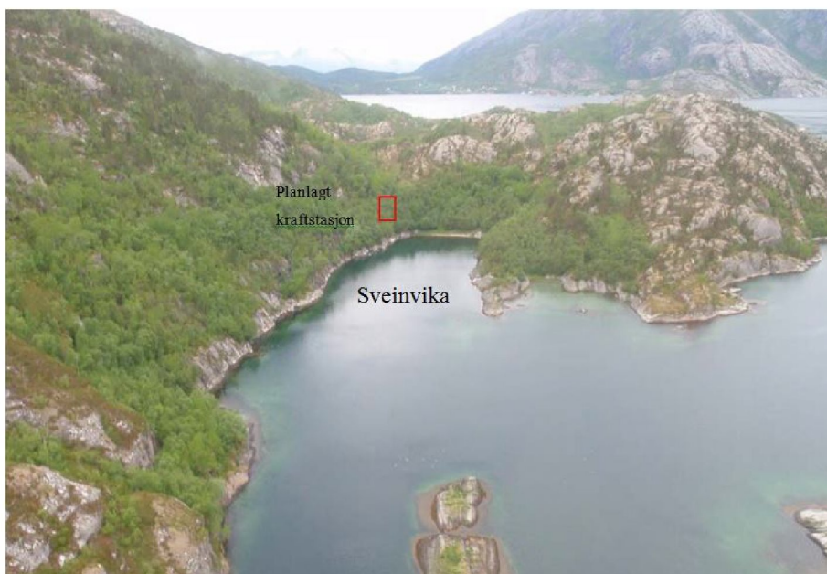
Bilde 8. Oversiktsbilde ved kraftstasjonsområde i Sveinvika
