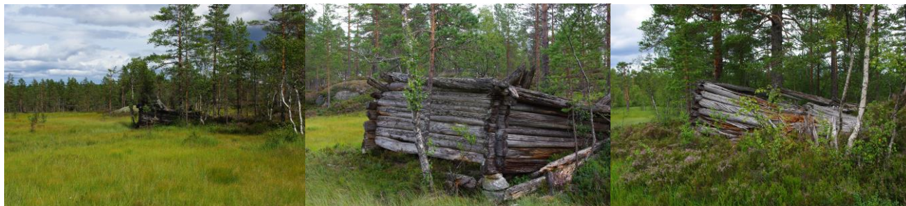
Figur 5. Til venstre og i midten den nordlegaste av høybuene. Til høgre den sørlegaste, som ligg nærast skogsbilvegen og den planlagde rørgatetraseen.
