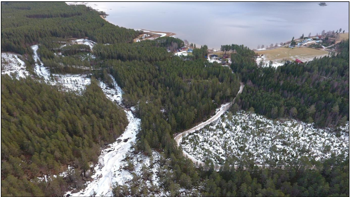
Figur 6: Foto tatt fra drone, viser nedre del av rørgata og kraftstasjonsområdet, samt Nisser i bakgrunnen.
