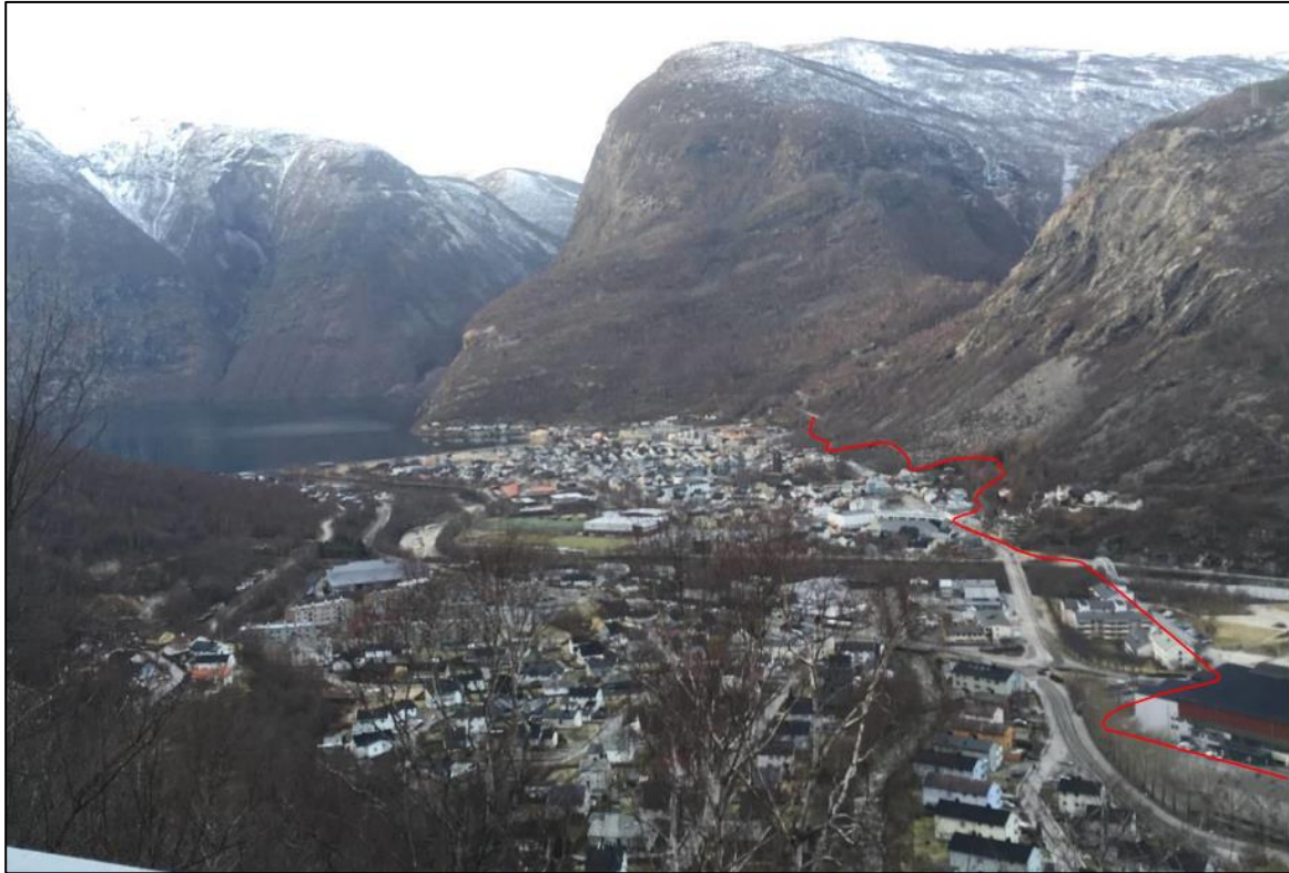
Figur 12: Oversiktsbilde med kabeltrasé inntegnet med rød strek. (Kilde: Fardal Energi, tilleggsopplysninger 15. mars 2017)
