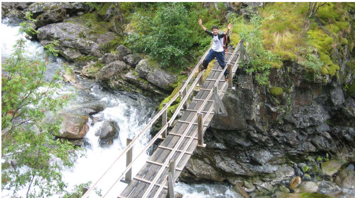
Gangbru over Fardøla
