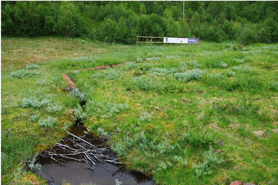
Figur 27. Det er lagt rør, samt kapp og kvister i myren nord for skisenteret for å gjøre det lettere å kjøre maskiner der når snøen skal prepareres.
