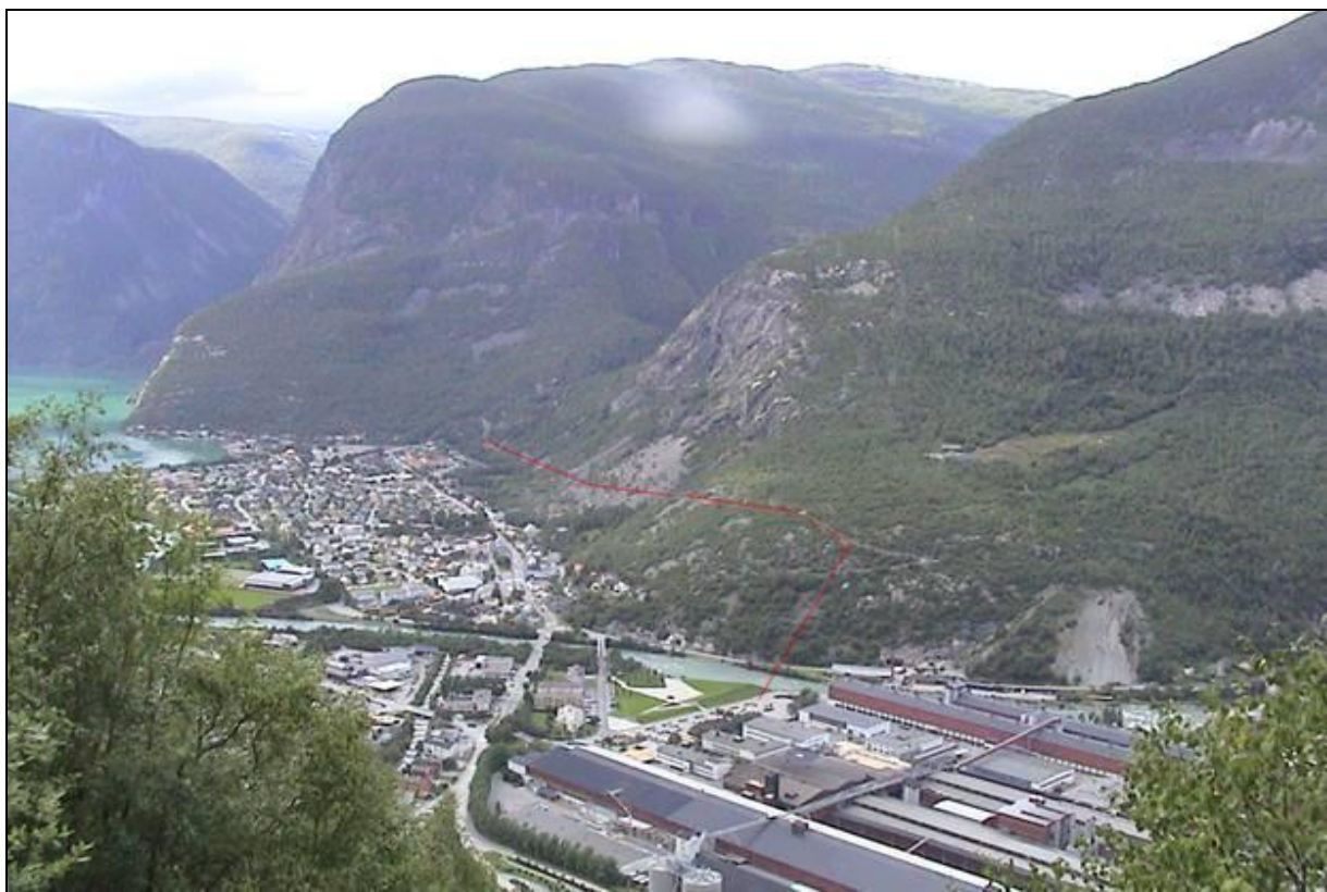
Figur 3. Øverst: Oversiktskart over planlagt nettilkopling til eksisterende 22 kV nett, via en 1,4 km lang ny linje (rød) og en 1,0 km lang jordkabel (brun). Nederst: Luftlinjetraséen (rød) tegnet inn på foto.
