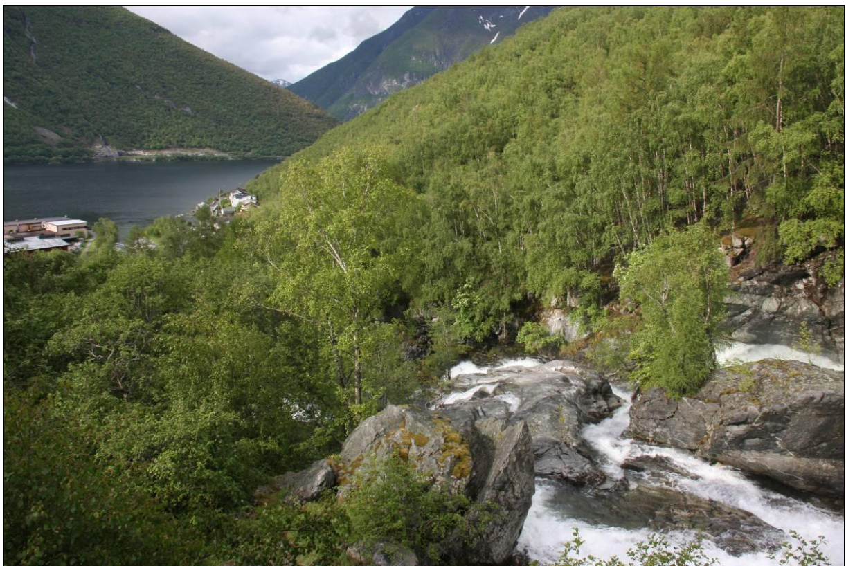
Figur 7. Alternativ 2: Utløpet fra Fardalen kraftstasjon vil ligge i nedre billedkant, på kote 38. Foto: Ole Kristian Spikkeland.
