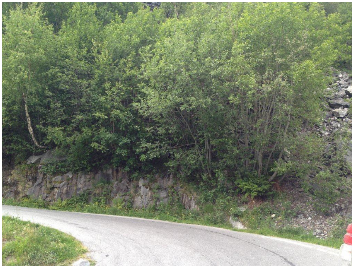
Bilde 1.1 Påhugg til adkomsttunnel
