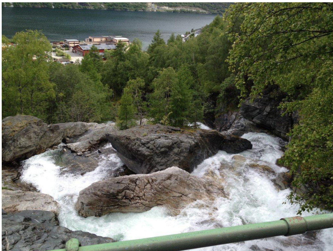
Bilde 3.4 Gangbru ca kote 50 og sett nedover
