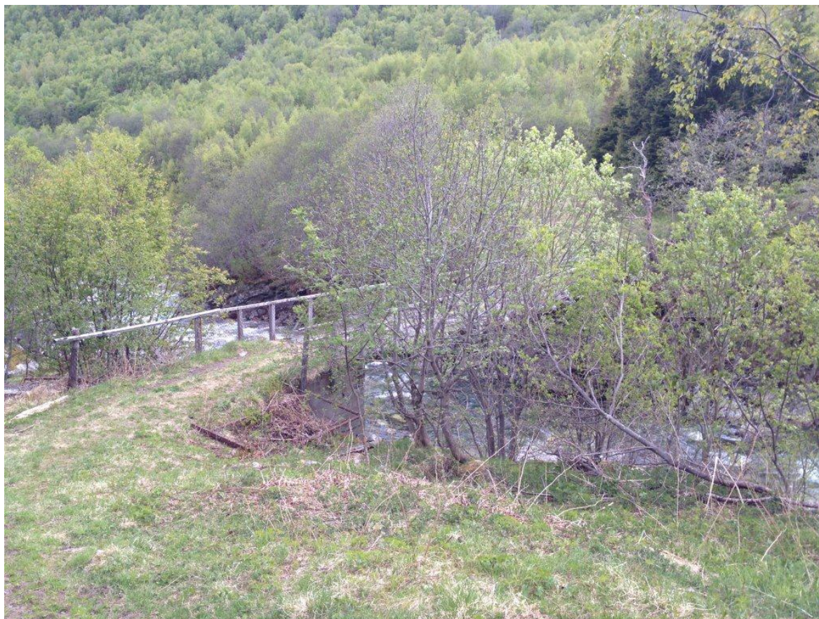
Bilde 2.1 Inntak og demning rett oppstrøms eksisterende bru
