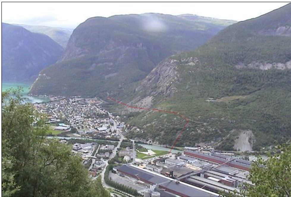
Figur 3. Øvst: Oversiktskart over planlagt nett-tilkopling til eksisterande 22 kV nett, via ei 1,4 km lang ny linje (raud) og ein 1,0 km lang jordkabel (brun), Nedst: Linjetraseen teikna inn på foto.
