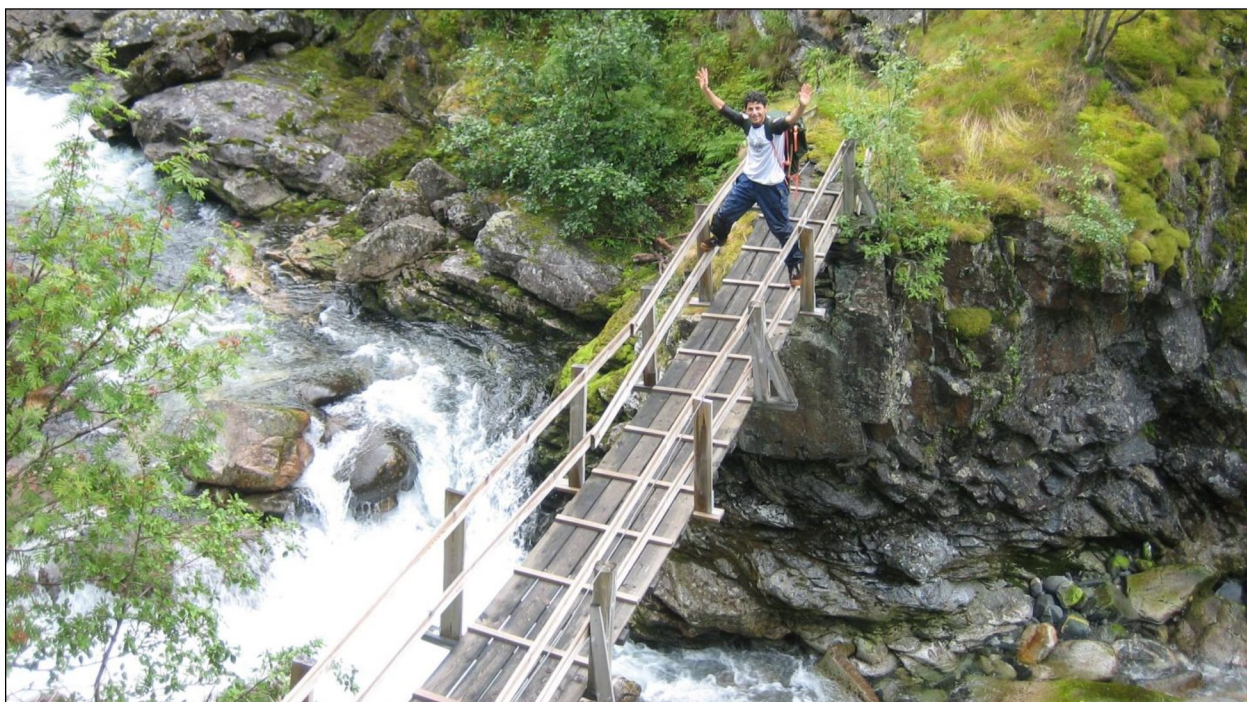
Gangbru over Fardøla.
