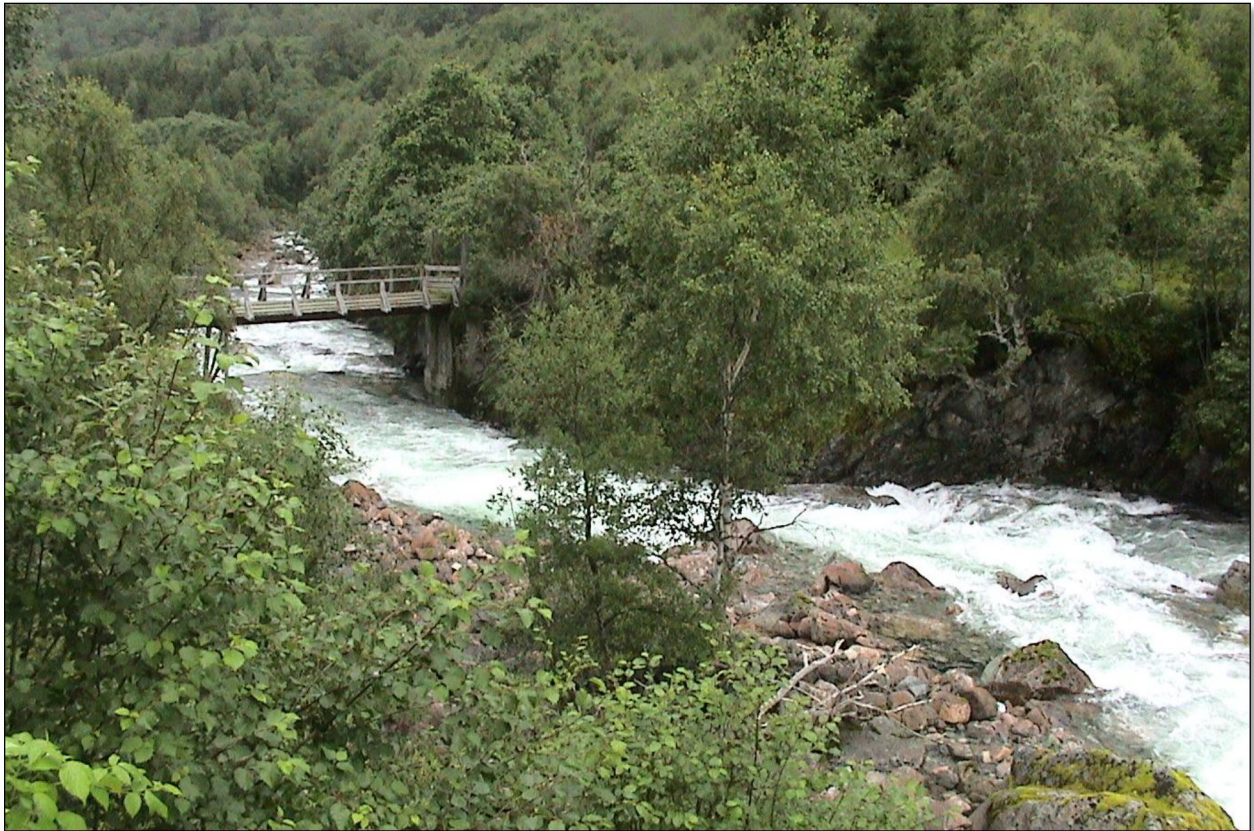
Bilete frå planlagt inntak og noverande bru på Haug
