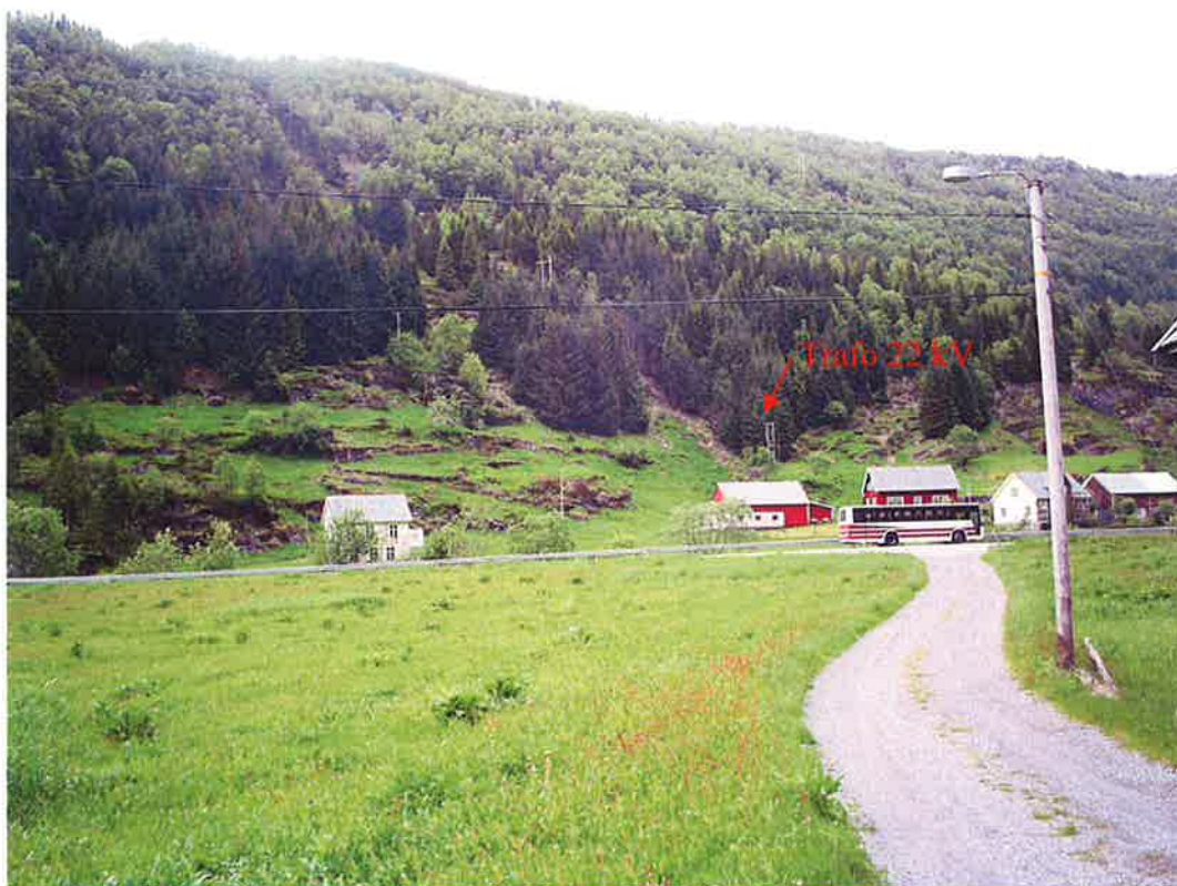
Bilde 14: Ev. påkoblingspunkt på eksisterende 22 kV linje i Bortnen.
