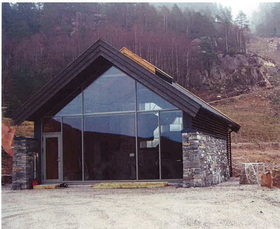
Bilde: Småkrafts standard for kraftstasjonsbygg (Ofte dal I).
