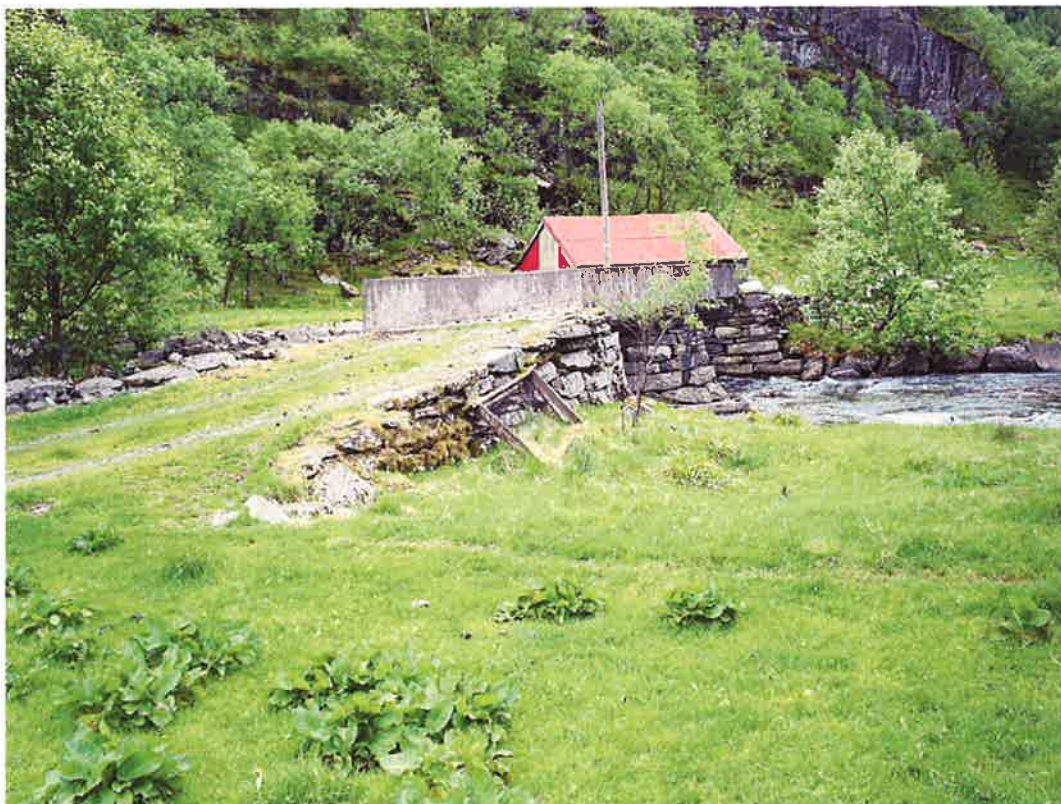
Bilde 13: Bru over Bortneelva ved Bortnen. Må oppgraderes for anleggstrafikk.
