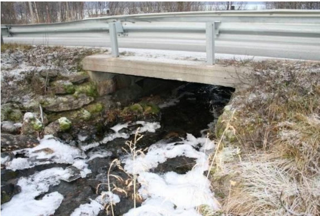
Bilde 20: Vestre elveløp under E6. Foto: Elvekraft
