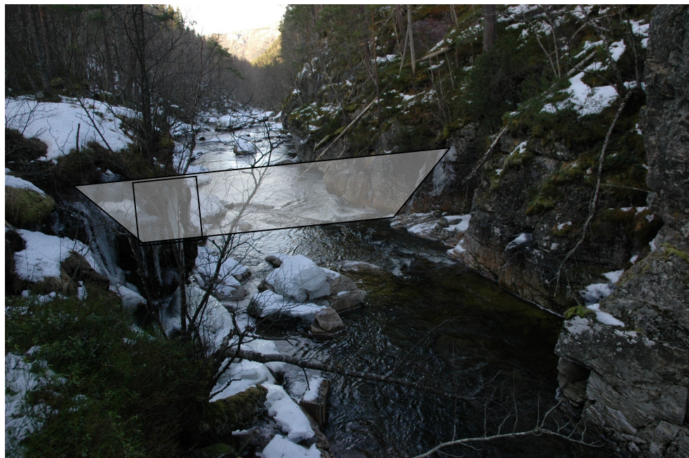
Bilde: Aktuelt inntaksområde med skissert dam og inntak. (Bildet er tatt oppstrøms planlagt dam.)
