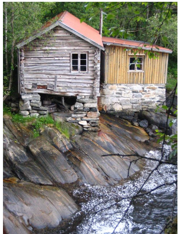
1I: Kvernhus og gammelt kraftverk ved utløpet i fjorden
