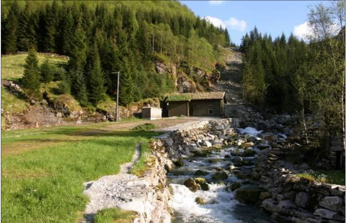
Figur 15. Eksempel på kraftstasjonsbygning med god arkitektonisk utforming og materialbruk tilpasset omgivelsene. Etter hvert som rørgatetraseen revegeteres vil synligheten av disse inngrepene være begrenset.
