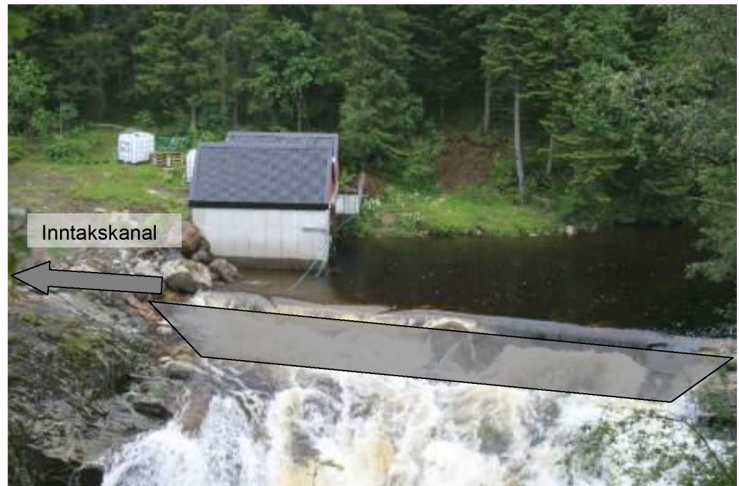
Bilde: Aktuelt inntaksområde med skissert dam og inntakskanal.
