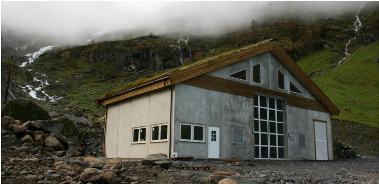
Figur 10 – Eksempel på kraftstasjon. Foto: Sofienlund, 2012.
