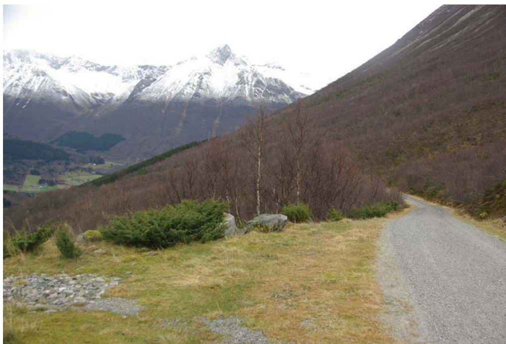
Midtre del av rørtraceen. Røret vil bli lagt på høgre sida av stølsvegen.
