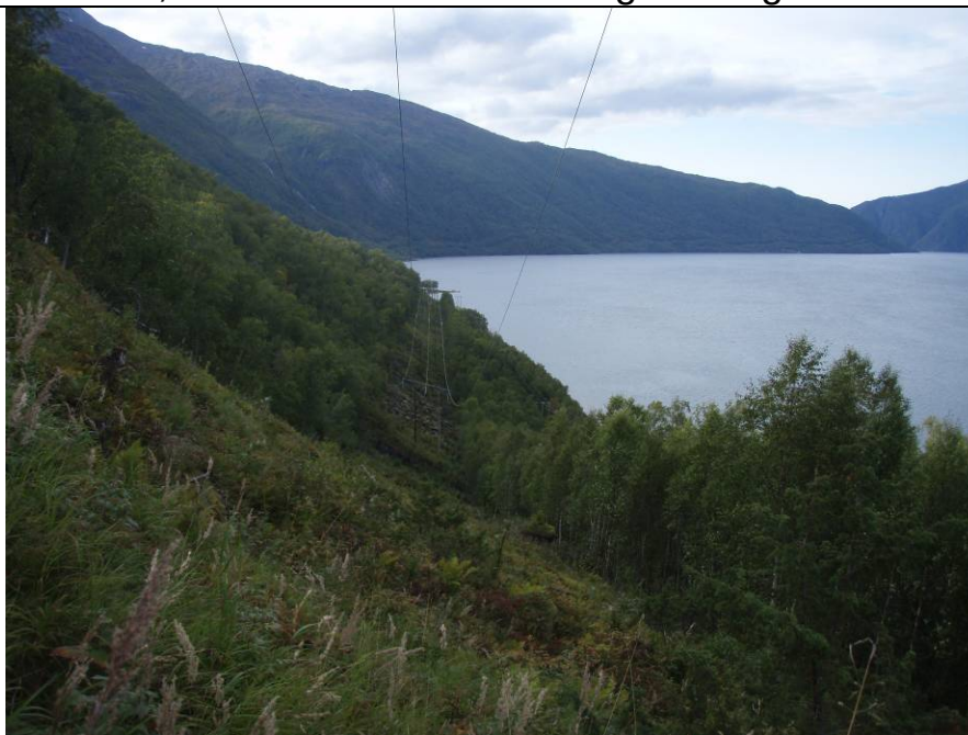
Bilde 9. Rørtraseen krysser kraftlinjer, både regional- og lokalnettet.
