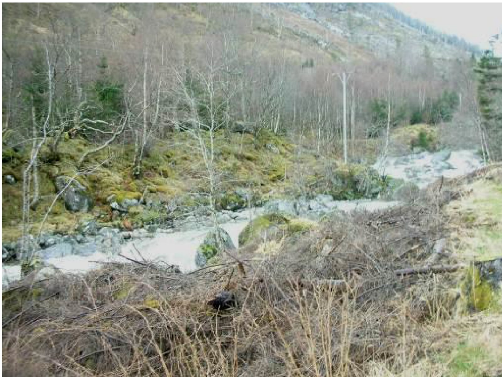
Bilde nr. 2. Område v/røyrgatetrase der eksist. 22kV linje kryssar elva.
