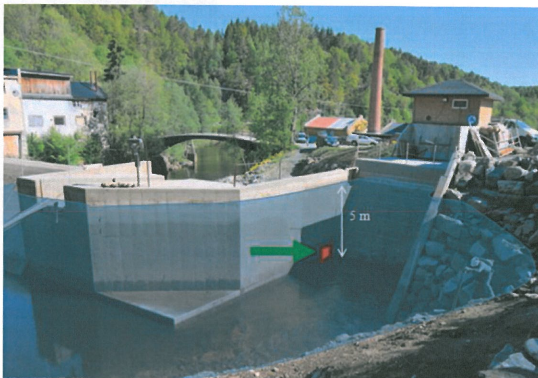
Figur 10 Inntaksdam ved Fosstveit kraftverk med bunnluke for minstevannføringslipp.
