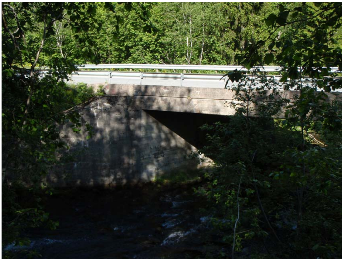
Nærbilde bru (R708) over Vigda
