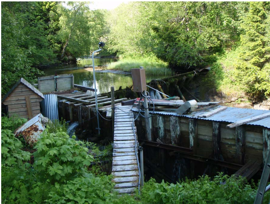
Eksisterende mikrokraftverk i Vigda
