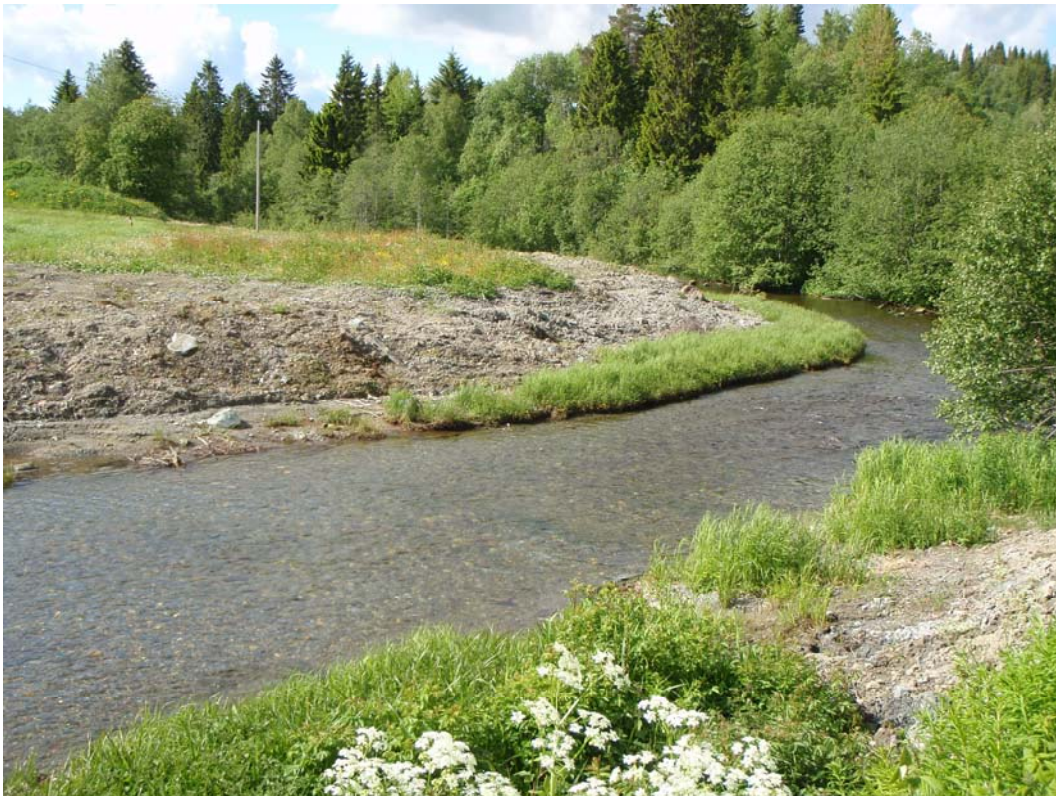
Oppstrøms inntaksdam. Synlig del av Vigda vil bli en del av inntaksmagasinet. Det er planlagte plastring langs leire-kant.
