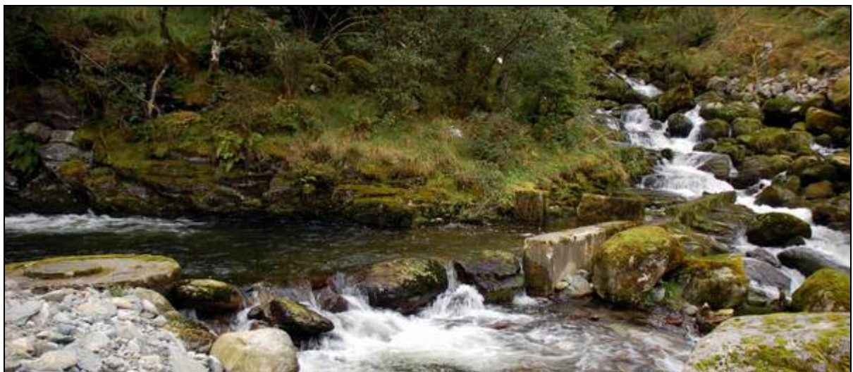
Figur 3. Utløpet fra Tussa Kraft AS sitt Dale Kraftverk, der det går en inntaksledning til anlegget (øverst), inntaksarrangementet i Litlebøelven (midten) og inntaksarrangementet i Dalselven (nederst) med inntakskum til venstre og ledekanal fra det søre elveløpet og bort til inntaksdam til venstre.
