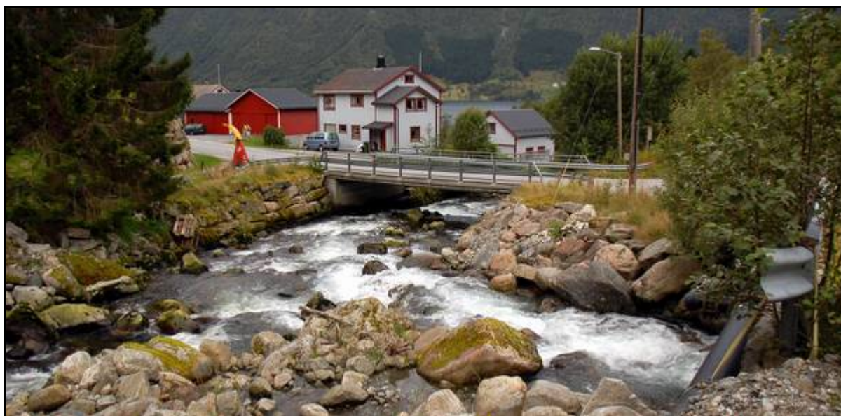
Figur 6. Dale sett fra fjorden, med rørgaten i lien og anlegget på neset midt i bildet ( øverst ). Dalselven ovenfor veien, like ved samløpet mellom Dalselven og Litlebøelven. Inntaksledningene skimtes til høyre på bildet. En av inntaksledningene skimtes til høyre på bildet ( nederst ).
