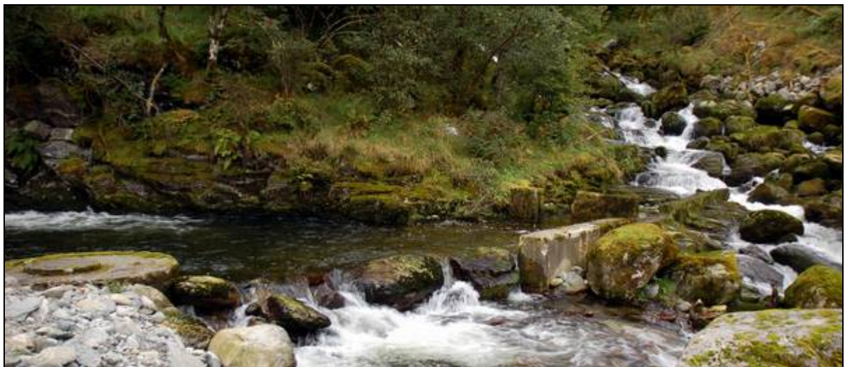
Figur 3. Utløpet fra Tussa Energi AS sitt Dale Kraftverk, der det går en inntaksledning til anlegget (øverst), inntaksarrangementet i Litlebøelven (midten) og inntaksarrangementet i Dalselven (nederst) med inntakskum til venstre og ledekanal fra det søre elveløpet og bort til inntaksdam til venstre.
