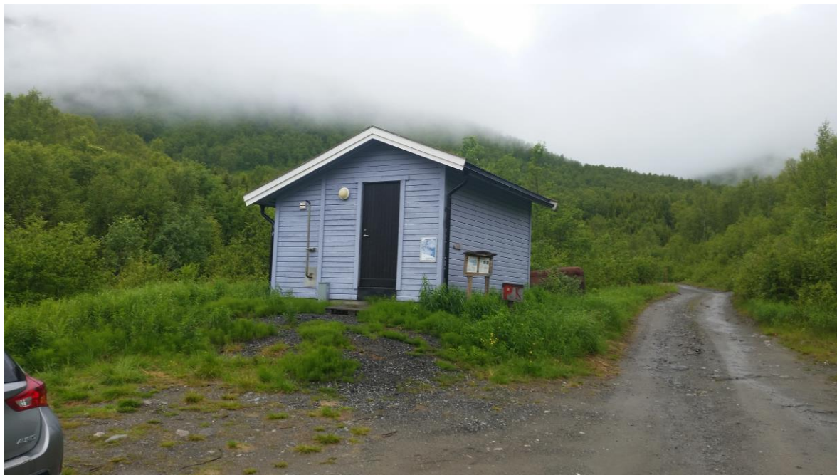
Figur 2-12 Start traktorvei nordsiden av Tverrdalselva. Foto Bekk og Strøm.
