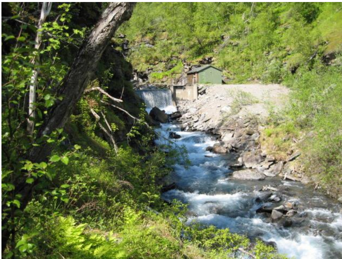
Figur 3-19: Kommunt vannverk på kote 85. Foto: Elvekraft.
