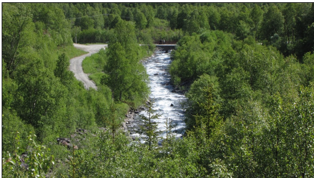
Figur 3. Nedre del av Tverrdalselva med område for planlagt lokalisering av kraftverk. Foto: Geir Arnesen.
