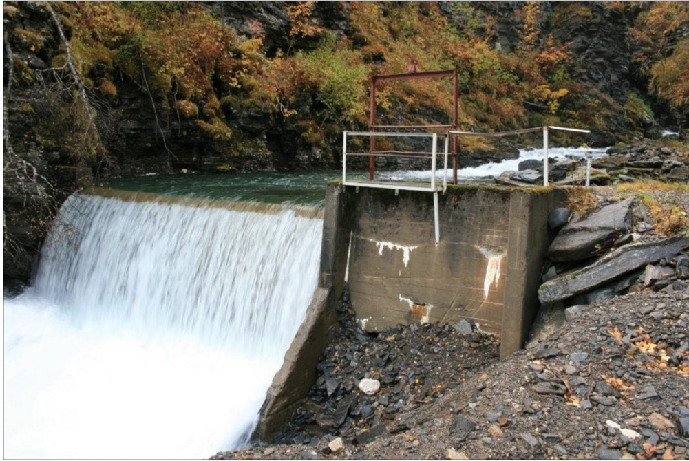
Figur 14. Endelig vandringshinder ved hovedinntak for drikkevannskilde. Foto: Bekk og Strøm.
