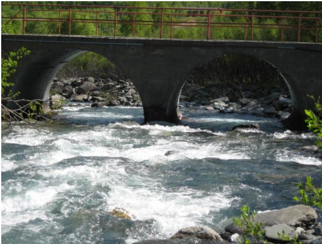
Bru over Tverrdalselva kote 237 sett fra oppstrøms side. Foto: Elvekraft.
