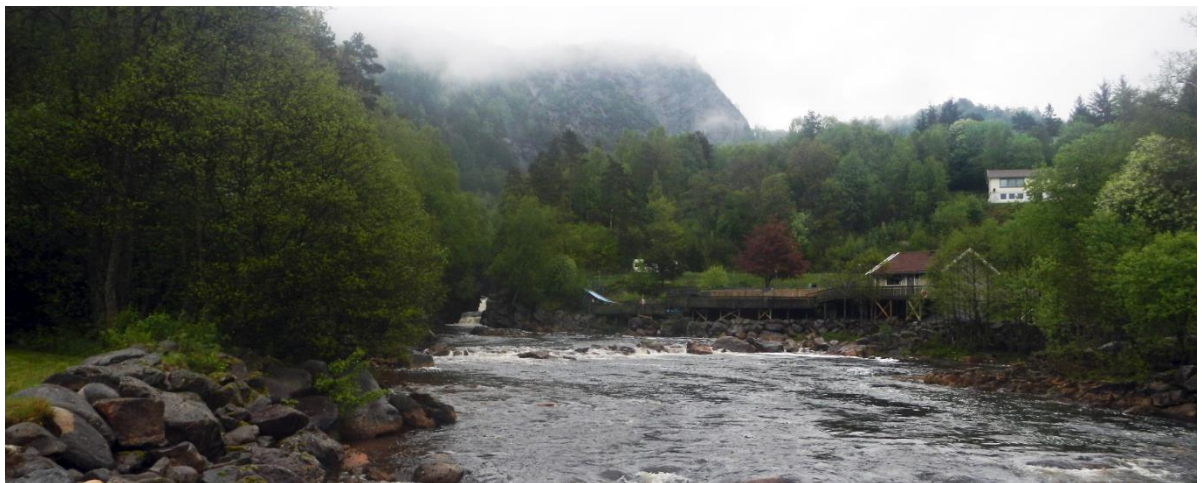
Figur 7 Bilde av kraftstasjonsområdet
