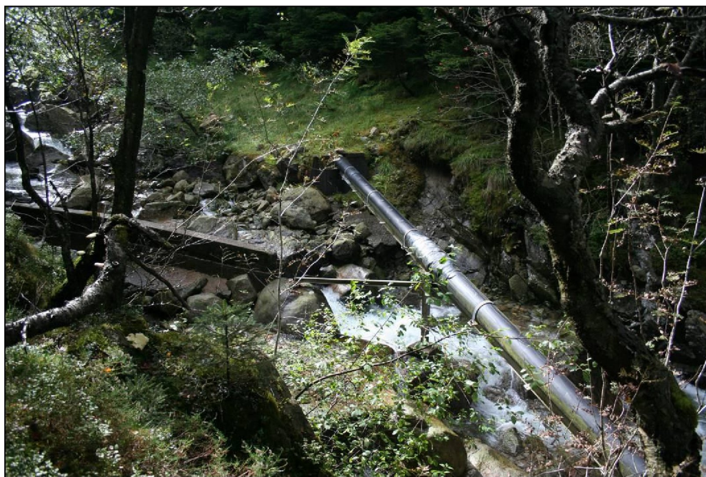
Figur 10. Ved Storhaug er det et vannverk som tar drikkevann i fra Eikeelva. I forbindelse med dette vannverket krysser vannrøret elven.
