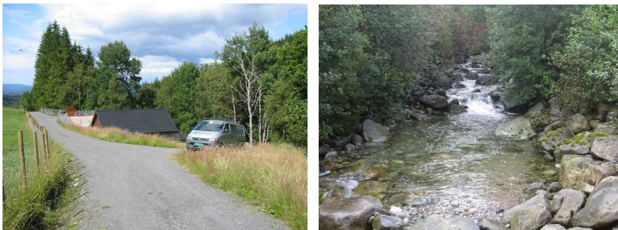
Figur 19 Uskedalen vassverk. Inntaket til vannverket er vist til venstre, kote 120.
