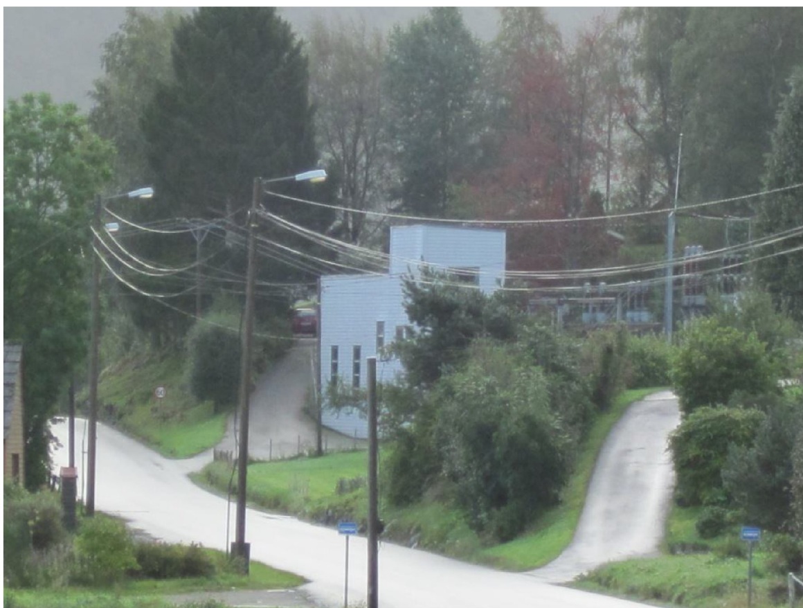
Figur 32 Trafostasjon, rett øst for Eikeelva (Foto: Elvekraft, 2009).
