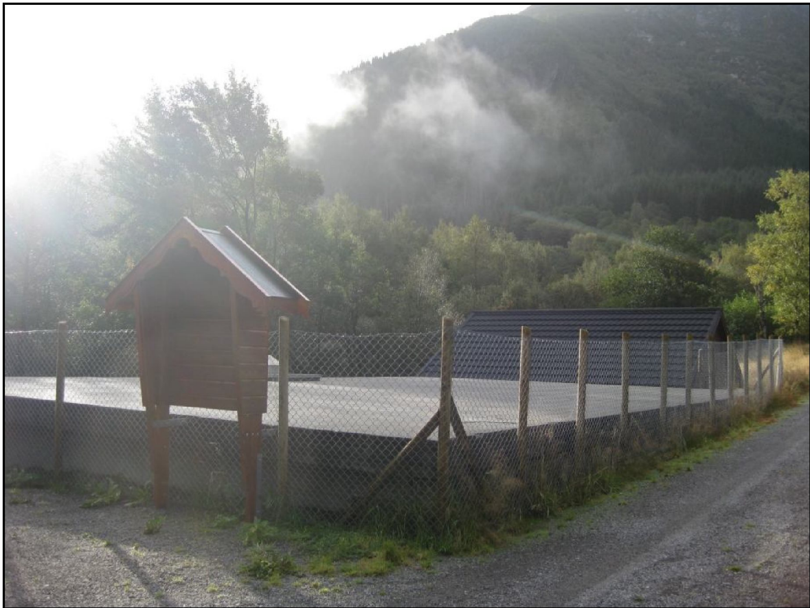
Figur 25 Uskedalen Vassverk (Foto: Elvekraft, 2009).
