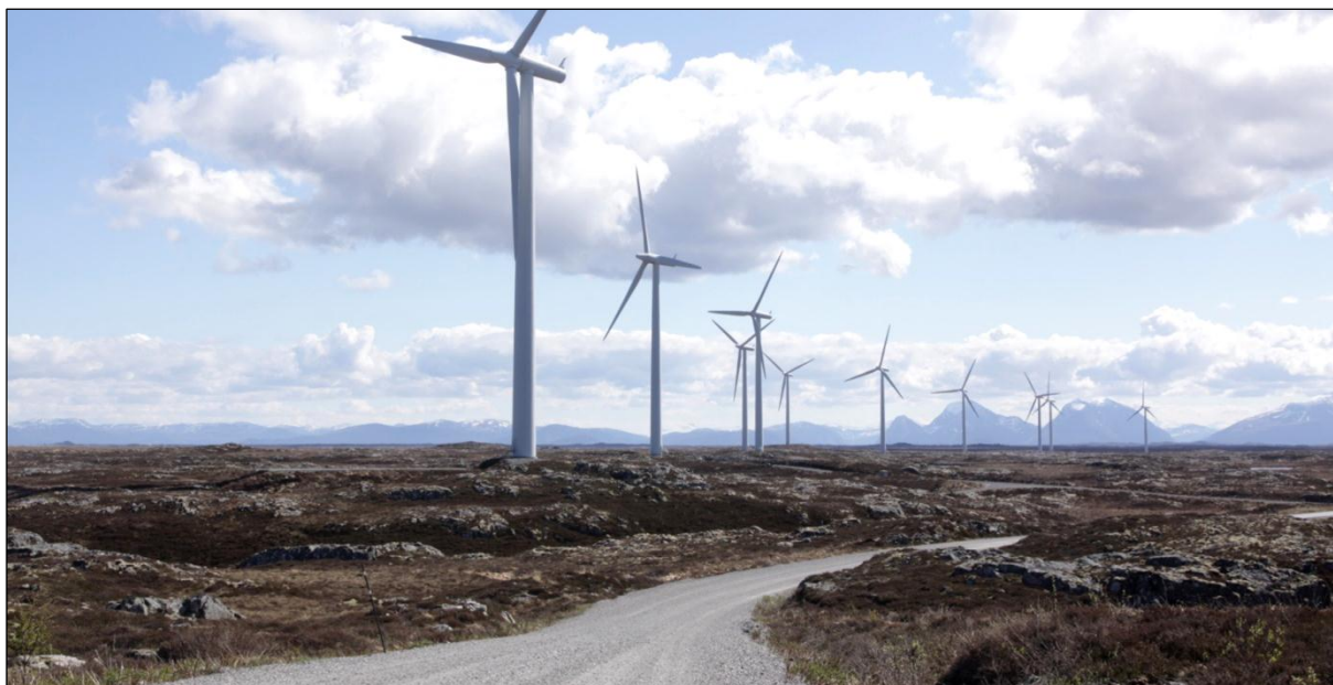
Bilde 1. Smøla vindkraftverk med internveger og vindturbiner. Vegene har normalt en bredde på ca. 5 meter og grusdekke.
