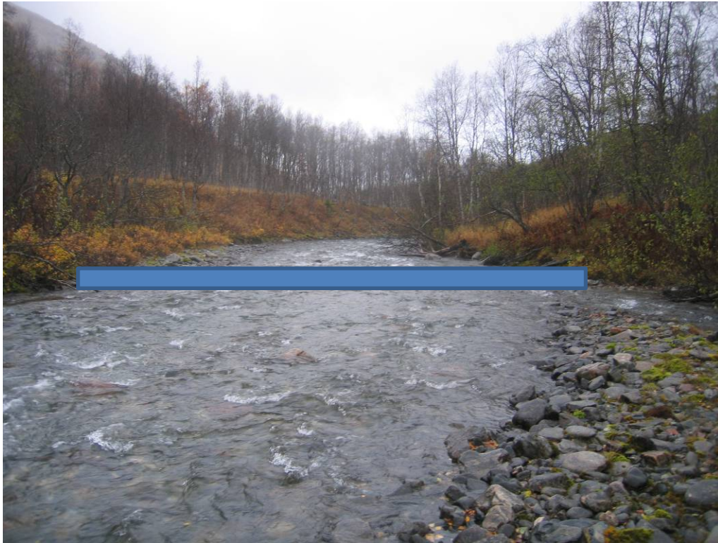
Inntaksområdet for Tverrelva kraftverk
