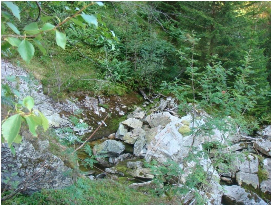
Bildet viser hovedinntak II i Dalseidmarkåni. Demning er tenkt i forkant der steinene ligger. Røret et 300 mm PE-rør og vil få innløpskanal i rennen som går innover i terrenget midt på bildet.
