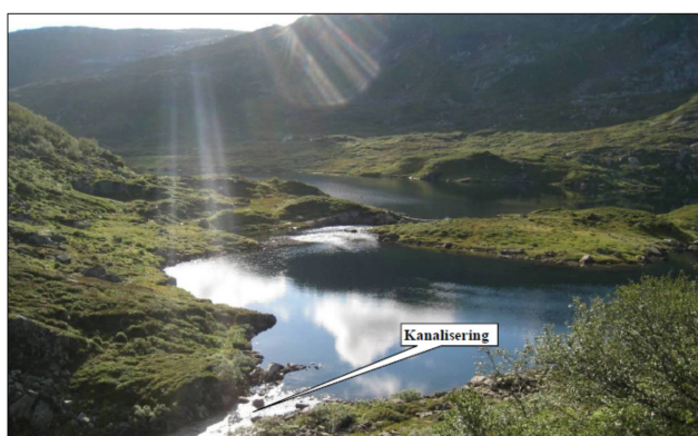
Fig. 29 Inntaksbassenget vert regulert med \pm 0,5 m. Det vert kanalisert noko i utløpet frå Kvålsdalstjørni.
