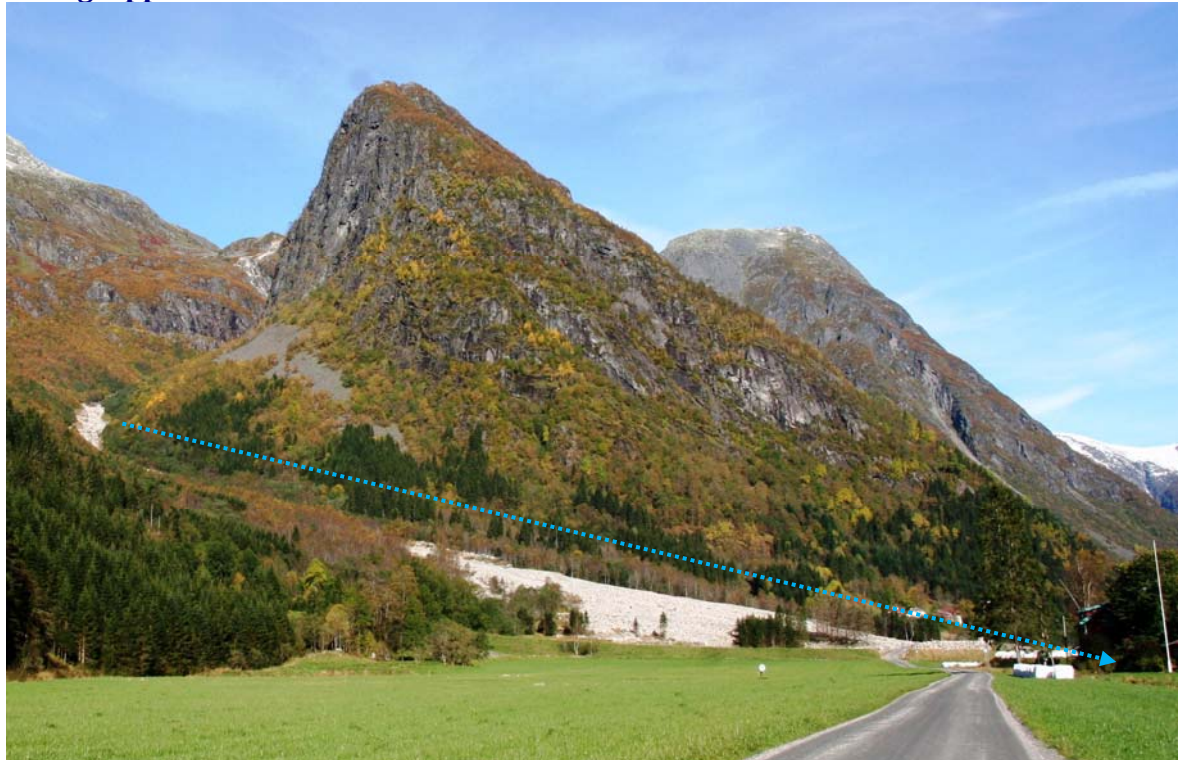
Bilde 3.1 Rørgatetraseen sett fra veien
