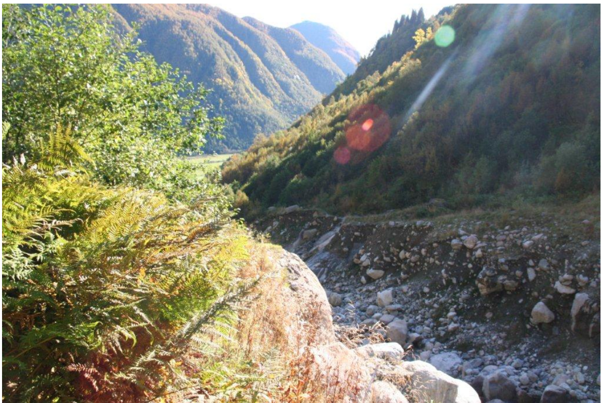
Bilde 2.2 Inntaket og nedover
