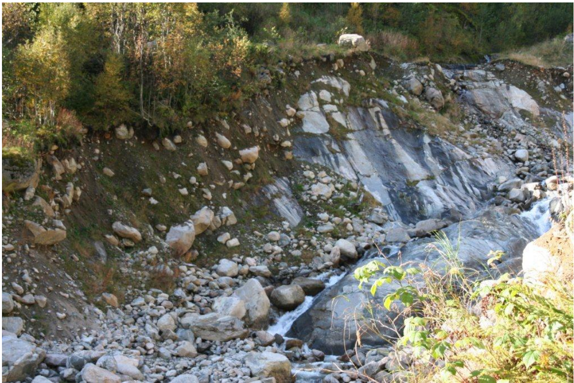
Bilde 1.2 Inntaket i elva på fjell
