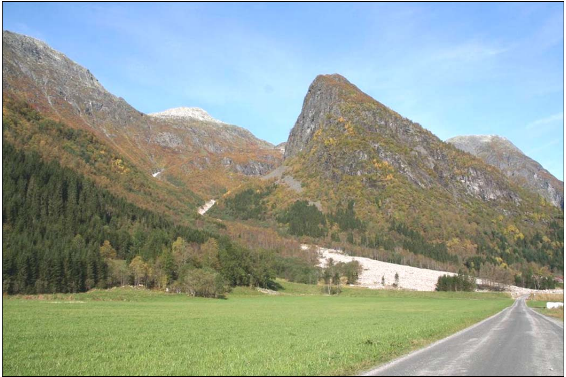
Figur 13. Nedre deler av Tverrdølas nedbørfelt i Supphelledalen, fotografert etter det store raset som rammet området 8. mai 2004. Inntaket er planlagt i elvedalføret sentralt på bildet, mens kraftstasjonen vil bli lagt i tilknytning til dyrket mark utenfor høyre billedkant. Rørtraséen vil gå i skogen bak elveløpet (foto 28. september 2007: Ole Kristian Spikkeland).
