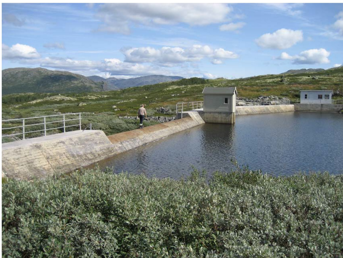
Figur 3. Eksempel på bekkeinntak. Noe tilsvarende inntak vil kunne tenkes benyttet ved inntak Gudmedøla. Foto: E-CO Vannkraft.
