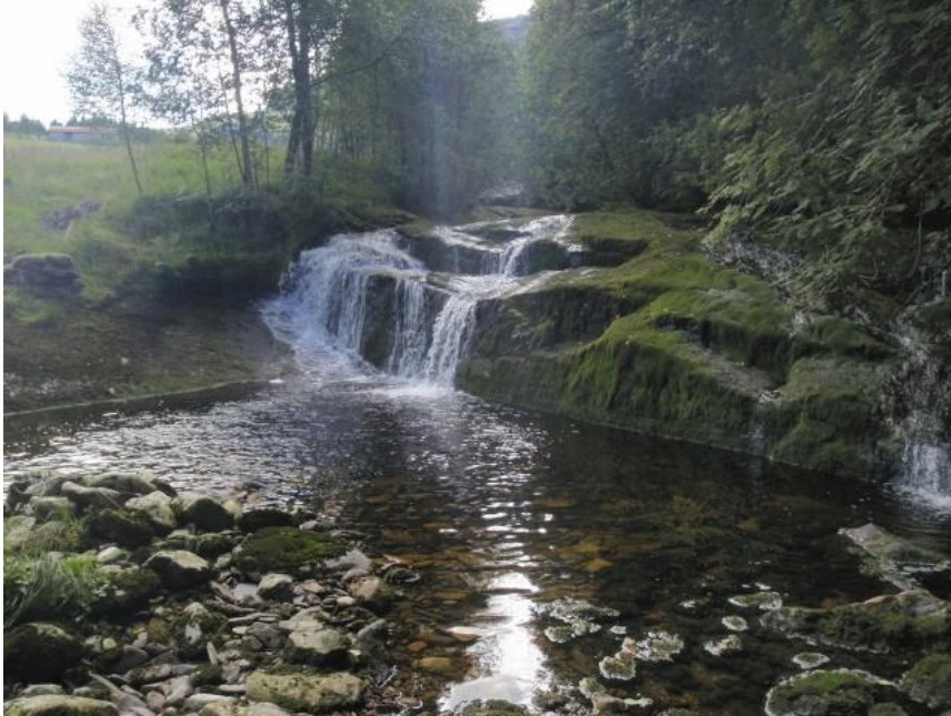
Figur 14 - Bilde som viser absolutt vandringshinder
