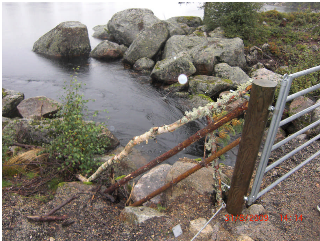
Bilde 11: Bilde viser del av broen over utløpet til Måsteinsvatn.
