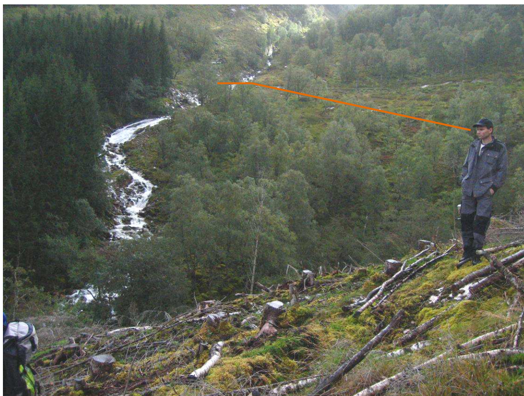
Bilde 2: Aurebotnelva, med inntaksdam og overføringsrør indikert.
