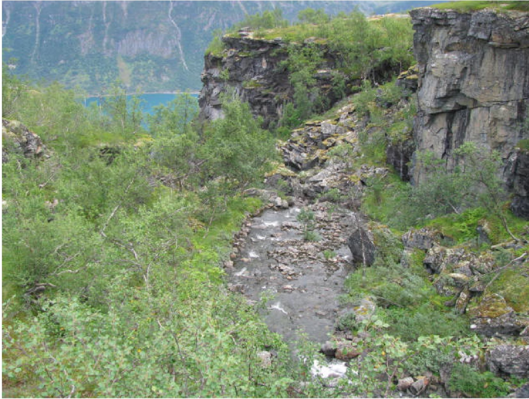
Like oppstrøms inntak, bilde tatt nedover mot inntak 13.08.09
