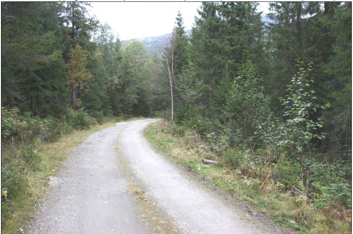
Figur 9. Rørgata vil krysse skogsveien i dette partiet like sør for Åkroken (foto 20. september 2009: Ole Kristian Spikkeland).
