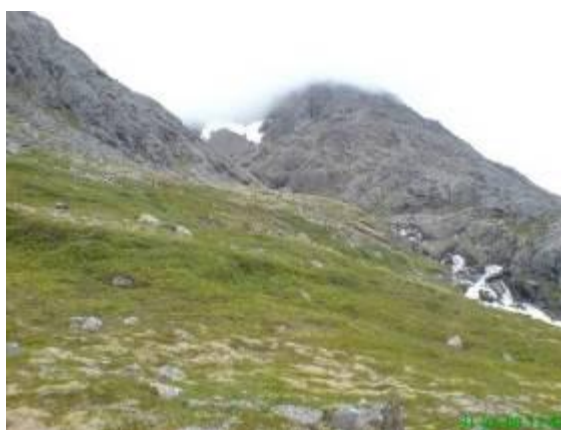
Vittneselva ved kote 230 sett oppstrøms, rør graves ned.
