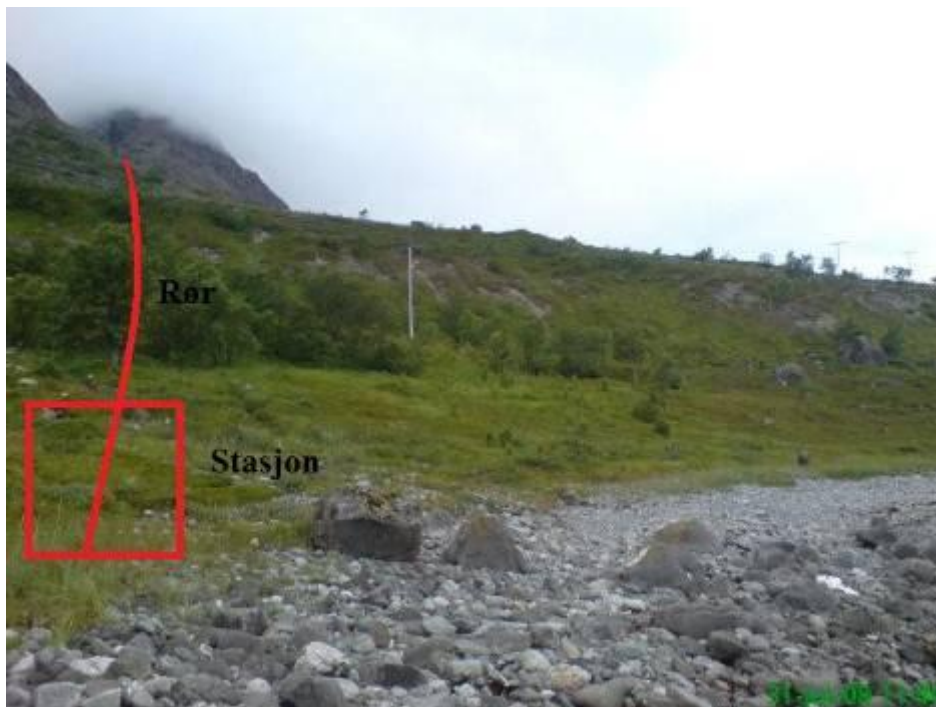
Stasjonsplassering ved sjøen på østsiden av Vittneset. 22kV kraftlinje vises på bildet. Foto: Elvekraft
