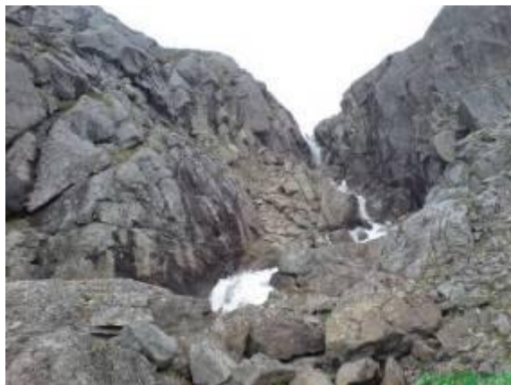
Elva ved kote 270, rør boltes på fjell til venstre
