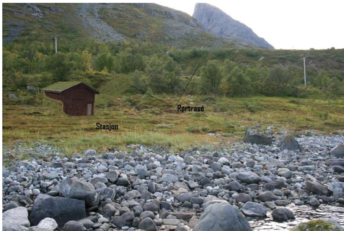
Småkraftverk sett fra sjøen ved Nordre Vittnesbukta, stasjonsbygning med rørtrasé i bakgrunnen.
