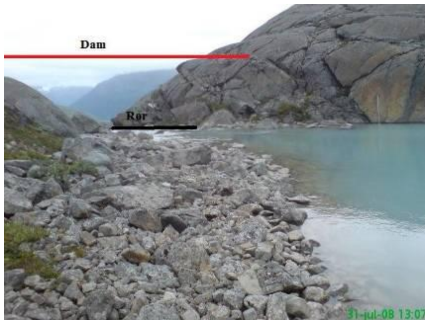
Damsted ved utløpet fra Nedre Vittnesvatn. Foto: HydroPool
