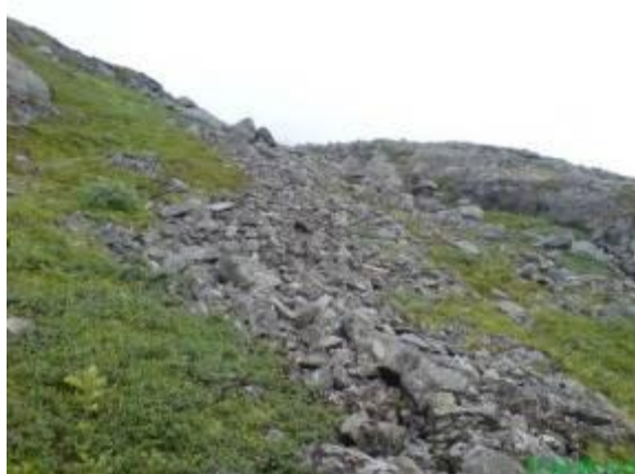
Rørtrase kote 180 sett oppover.
