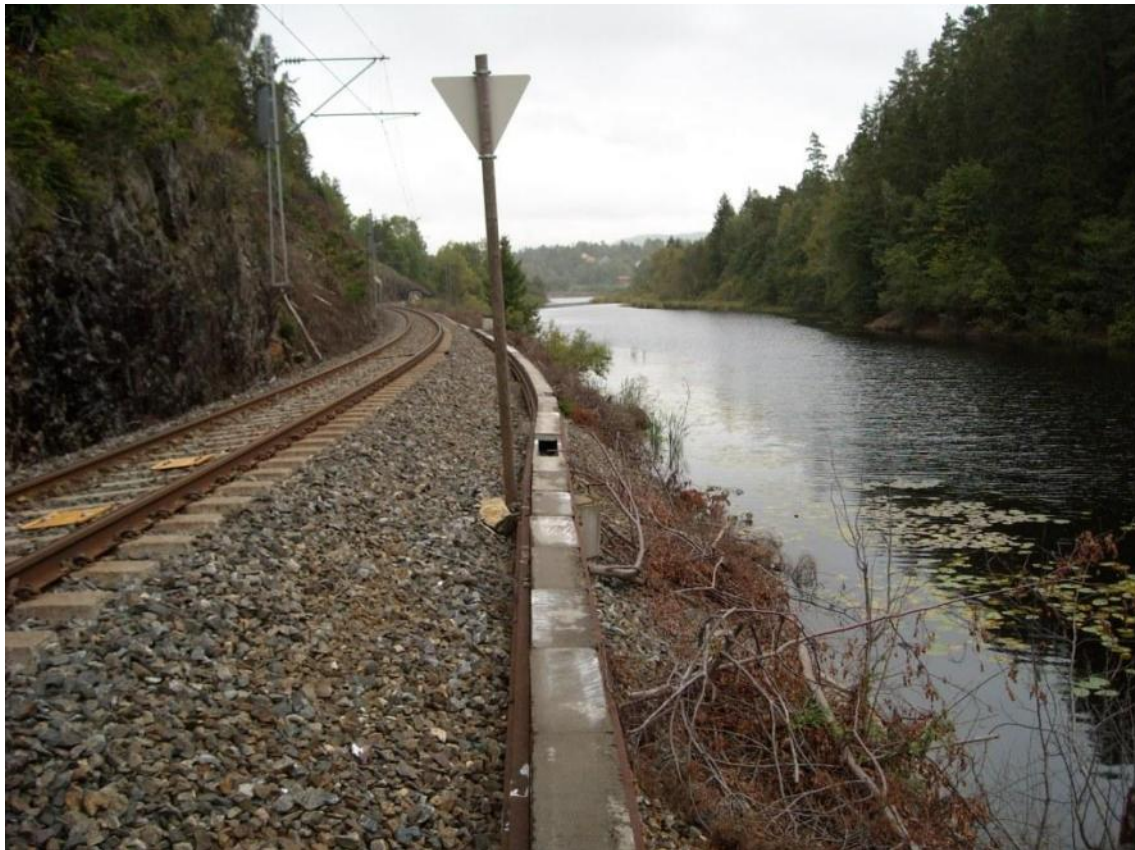
Jernbanefylling i sørenden av Bondivann. Foto: Asker kommune.
