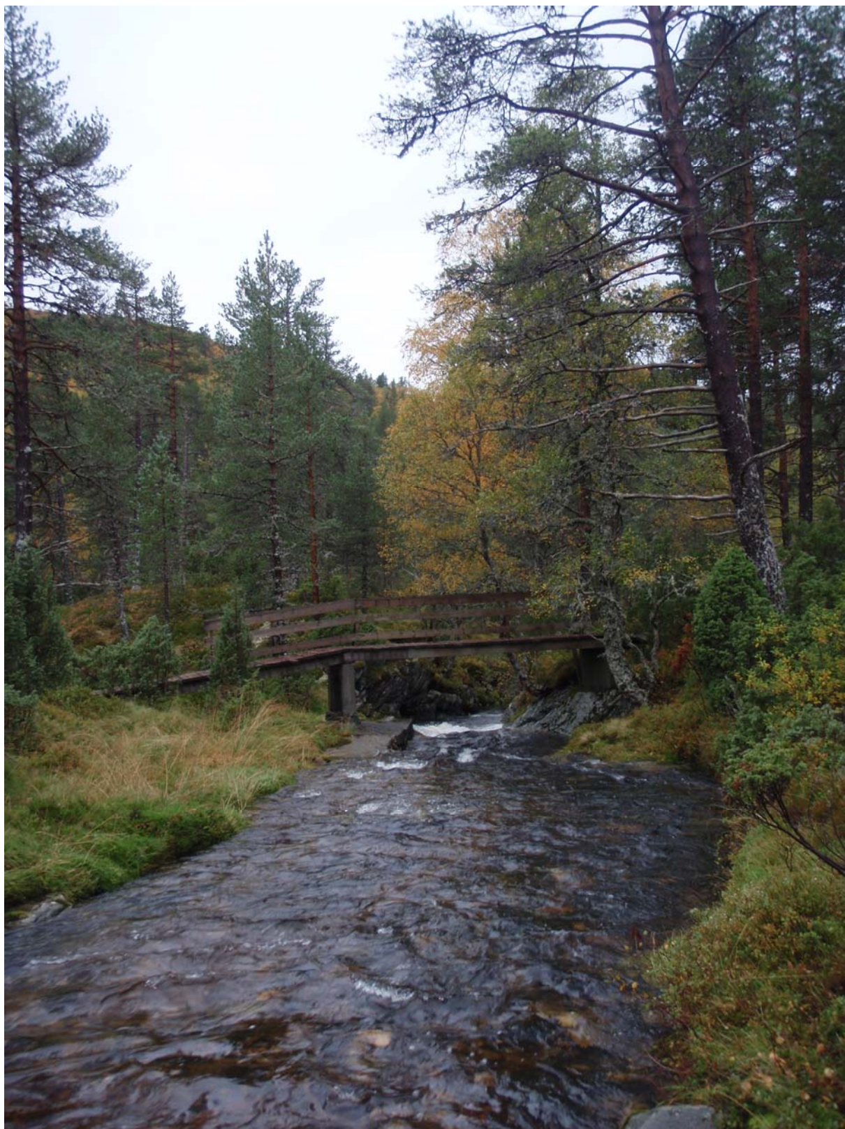
Figur 6, Brua over til Inderåsstøylane, ovanfor inntaket
