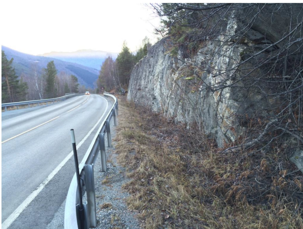
Fra kraftstasjonstomt mot elva. Planlagt nedgravd avløpsrør i vegkanten/vegrøft
