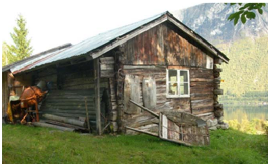
Figur 3-11 SEFRAK.-bygning på gården Lia. Bygningen var opprinnelig bolighus på gården, men er i dag i brukt som smie og snekkerverksted. Foto B. A. Hellen
