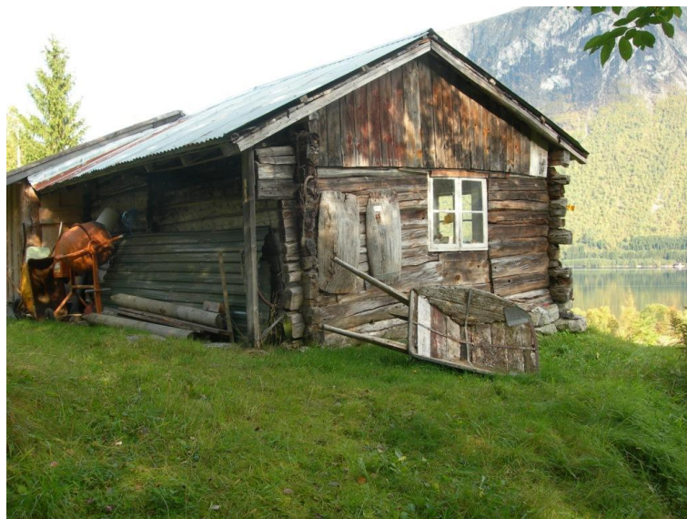
Figur 11. SEFRAK.-bygning på gården Lia. Bygningen var opprinnelig bolighus på gården, men er i dag i brukt som smie og snekkerverksted. Foto B. A. Hellen.
