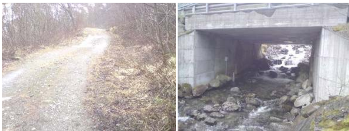
Figur 1-2 Dagens situasjon. Bilde til venstre viser en vei som følger Stokkelva fra E136 og opp til Hovdesetra som ligger ovenfor hovedinntaket. Bilde til høyre viser E136 som krysser Stokkelva like ved utløpet i Innfjorden.
