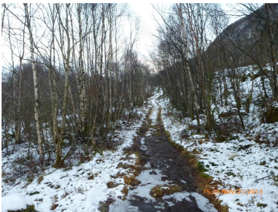
Bilde 15. Rørtrase til venstre. Krysser vei bak i bilde og går mot inntak. (bilde oppover)
