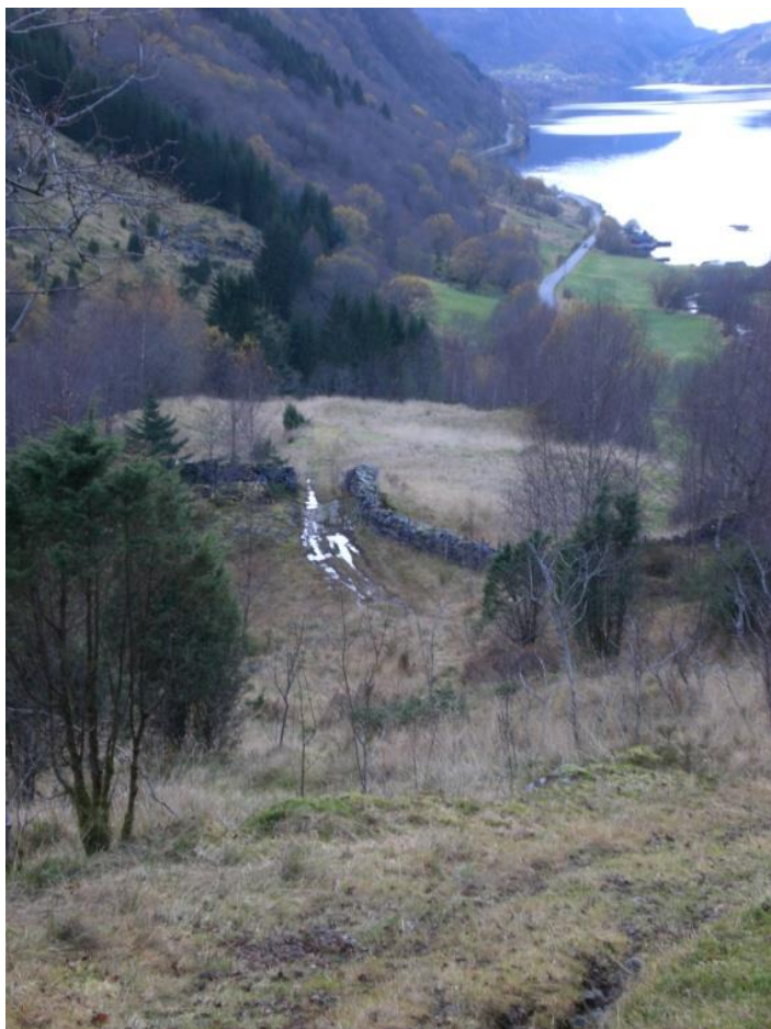
Bilde 11. Rørtrase litt til høyre i bilde.
