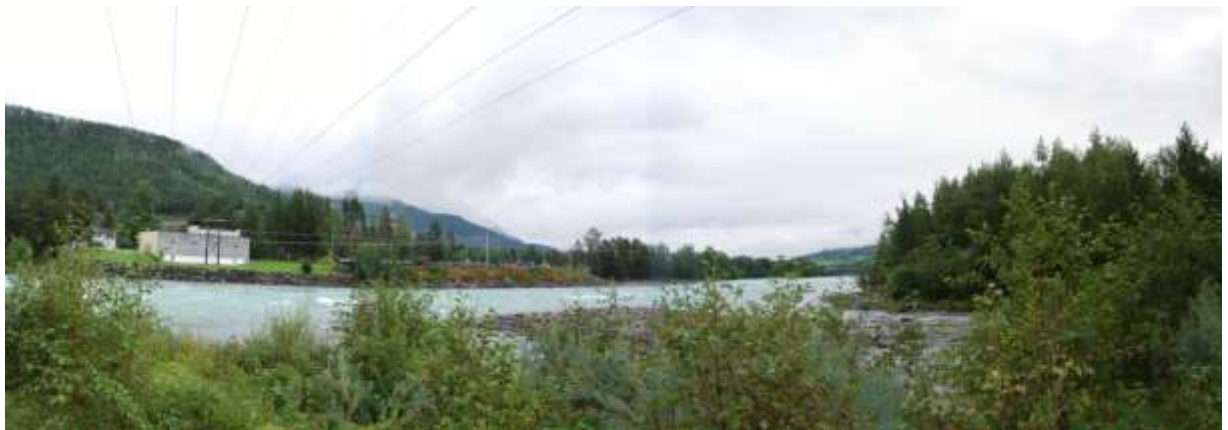
Bilde 6. Transformatorstasjonen på Kåja med flere kryssende kraftledninger over Lågen.
