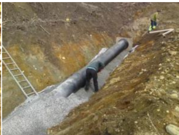
Bilde nr.8 viser rørlegging med god understøttelse.
