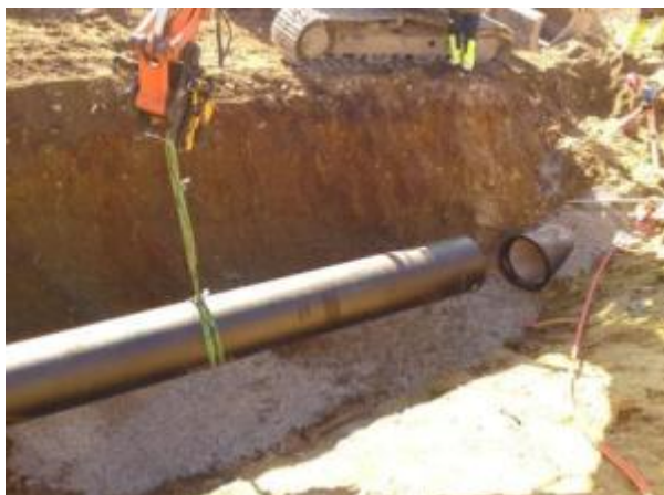
Bilde nr.7 viser rørlegging av duktile rør
