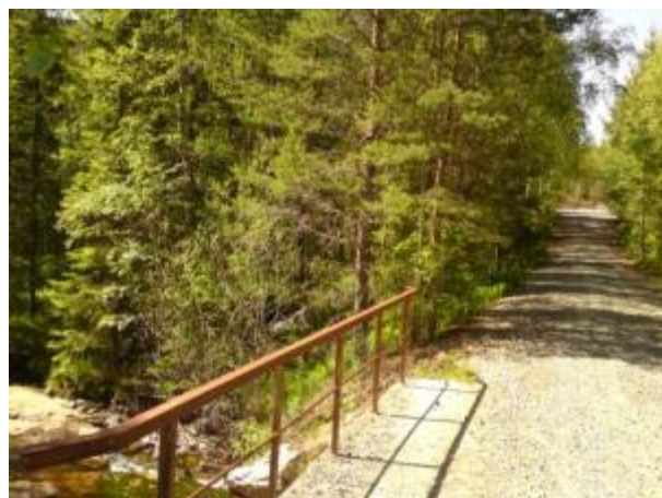
Bilde 10 viser stikk vei med bru over Esperåa. Foto juni 2009
