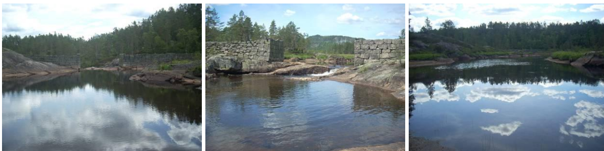
Bildene over viser gammel fløtningsdam som planlegges restaurert og brukt til inntak.
